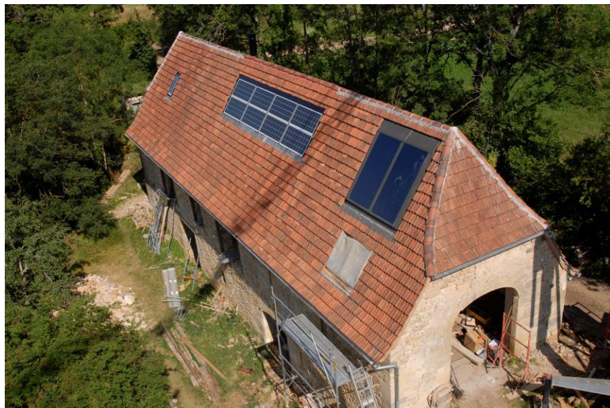
Source : Stéphane Leitenberger – chantier dans le Grand Figeac - 2012
