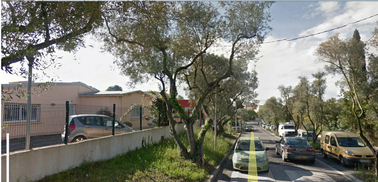
Muret de moins de 120cm, sans plantations
