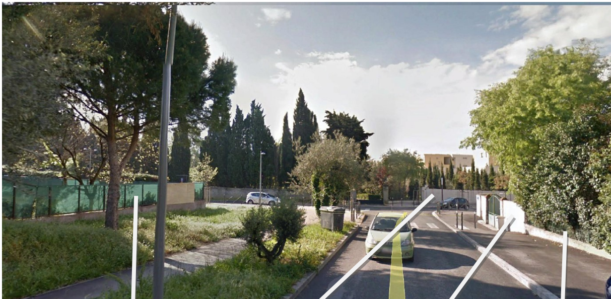
Muret de moins de 120cm, grillage doublé d'un pare-vue
