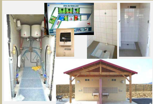
Aires récentes : sanitaires individuels, local technique équipé d'un coffret de paiement et comptage des fluides, abri avec évier, prises électriques et point d'eau pour machine à laver
