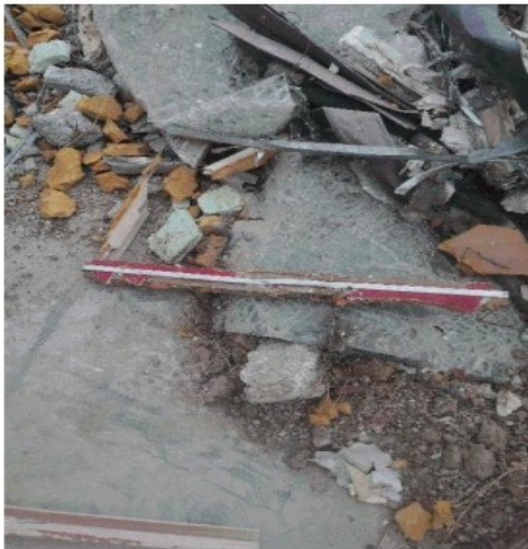
prélevé - idem P001 : RDC / tas de gravats 2 - Plaque- (Présence d'amiante)
