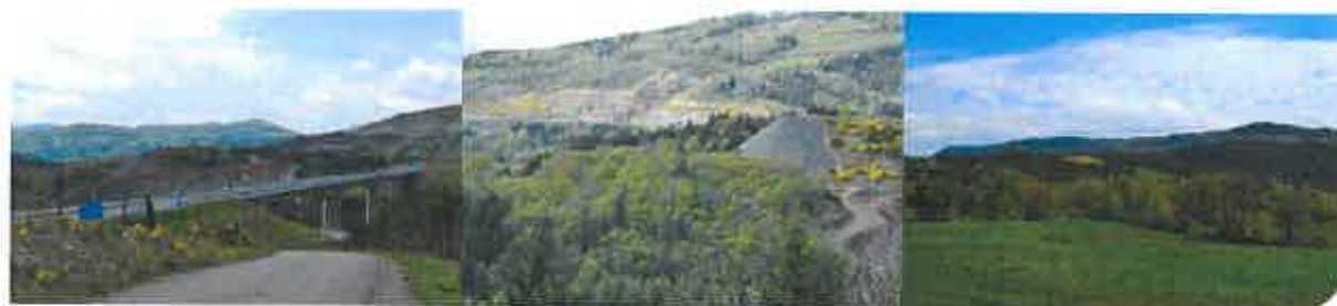
L'Autoroute 75 et la RN 88 forment les principales barrières écologiques dans ce secteur rural riche en réservoirs biologiques
