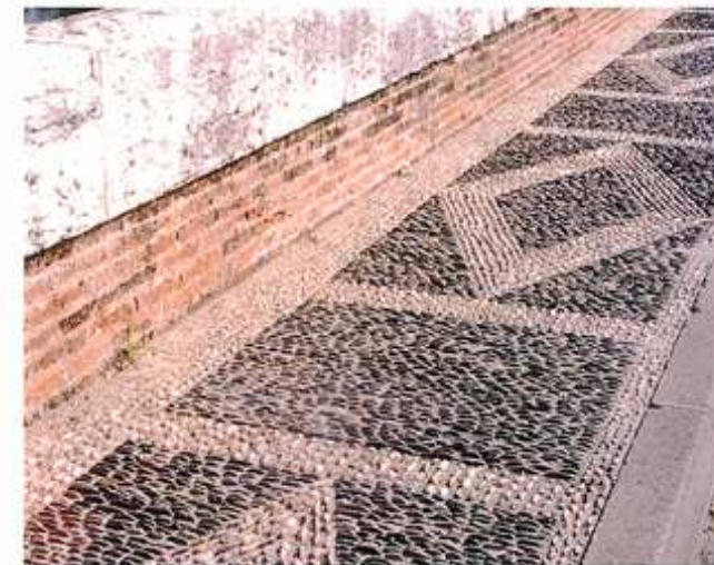
A Montauban comme à Moissac, les sols des ponts sont réalisés en calades, dessins géométriques de galets pris dans la rivière.
