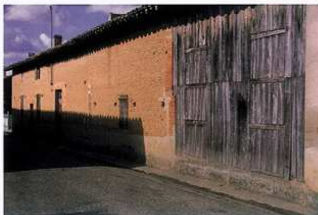
Bâtiment agricole en brique crue à Finhan
