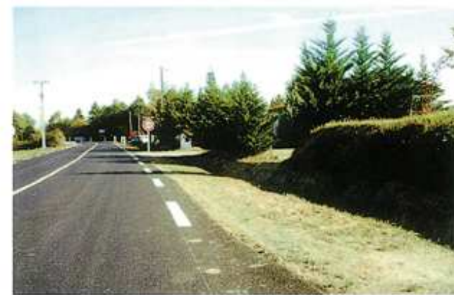
Mêmes maisons prises depuis la RD 8 : effet de banlieue linéaire
