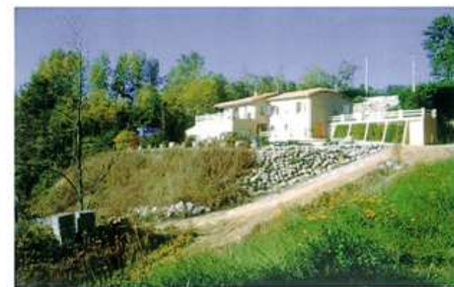
Déblais, remblais, enrochement, talus, soutènement, ...: le résultat d'une urbanisation banale sur les pentes. Ici à Reyniès.
