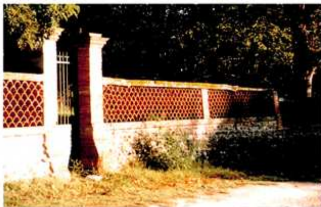
Exemple de clôture de jardin vers Verdun-sur-Garonne
