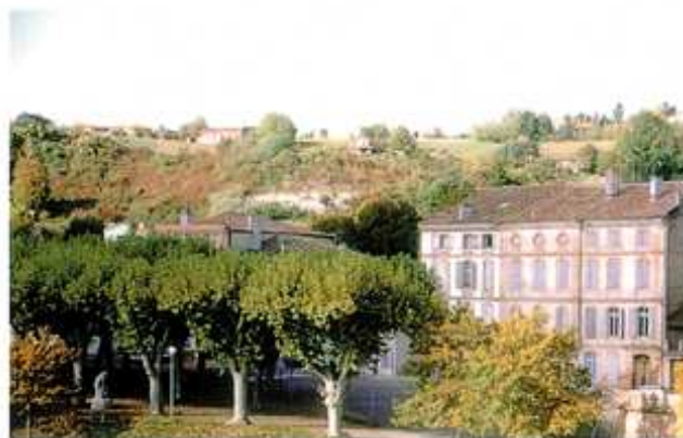
Urbanisation du coteau du Tarn à Moissac
