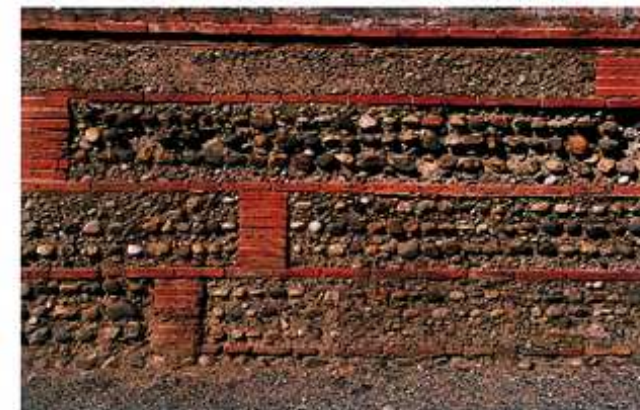
Autre mur de brique et galets à Saint-Porquier
