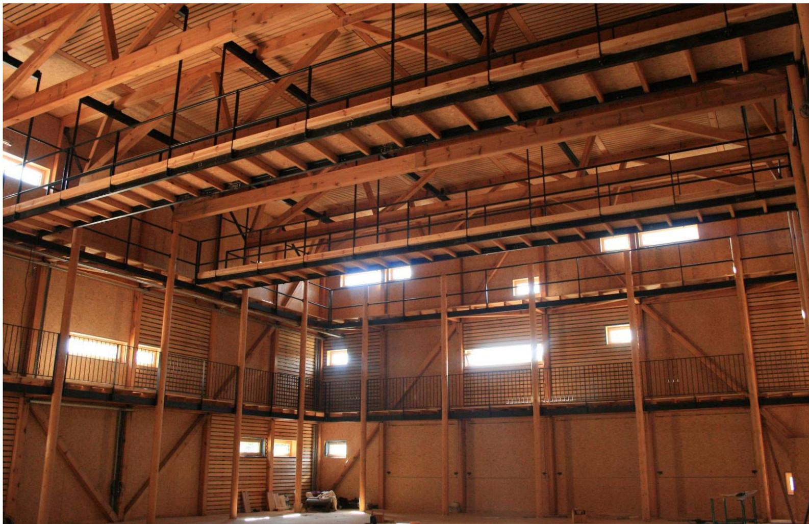
Structure porteuse et ossature en pin Laricio de Corse
