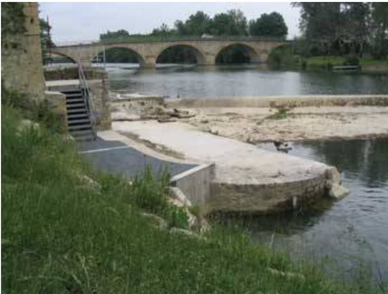
Figure 8 : Passe à poissons au seuil de Saint Laurent d'Aigouze (eptb asso)
