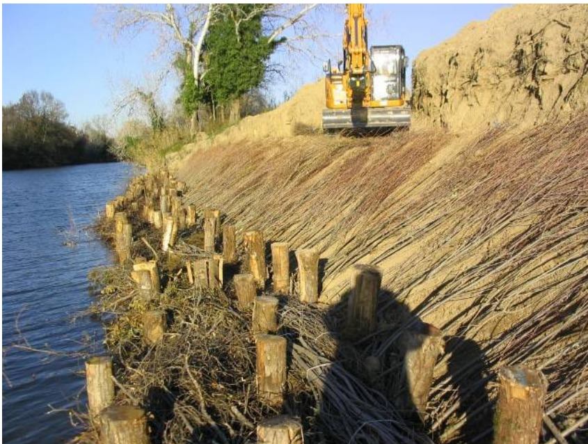
Figure 6 : Protection de berges par génie végétal (SIAV)
