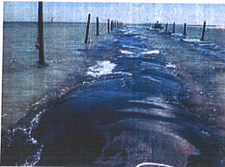
Vue d'un tube géotextile en Australie
