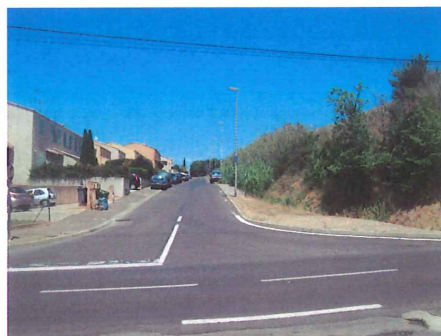
Carrefour Crouzette / Badones et talus de la RD612
