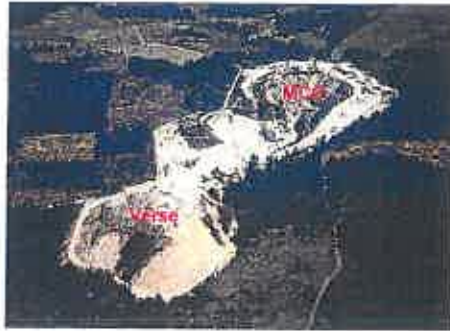
Vue aérienne du site en fin d'exploitation (1988)
