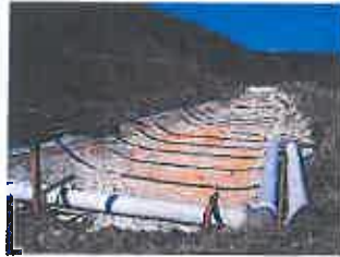
Étanchéification bassin soude en 2012
