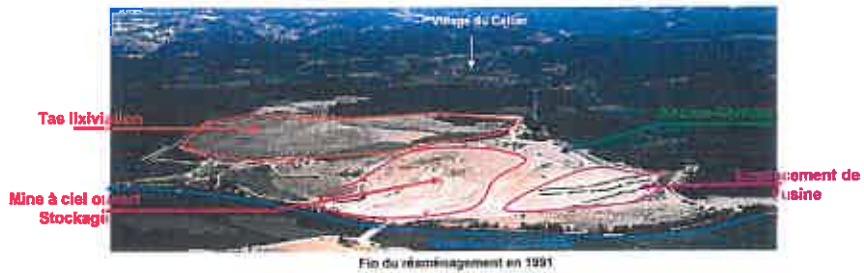
Fin du réaménagement en 1991
