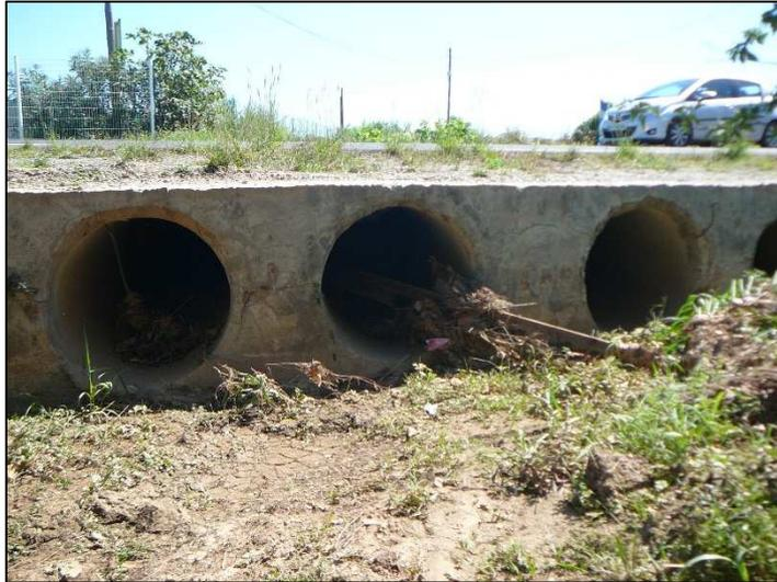
La platitude des réseaux engendre aussi dans certaines sections des dépôts de sédiment qui limitent les sections d'écoulement, information difficile à intégrer de façon quantifiée dans le modèle et qui perturbent aussi le calage du modèle<sup>1</sup> (points V3).
