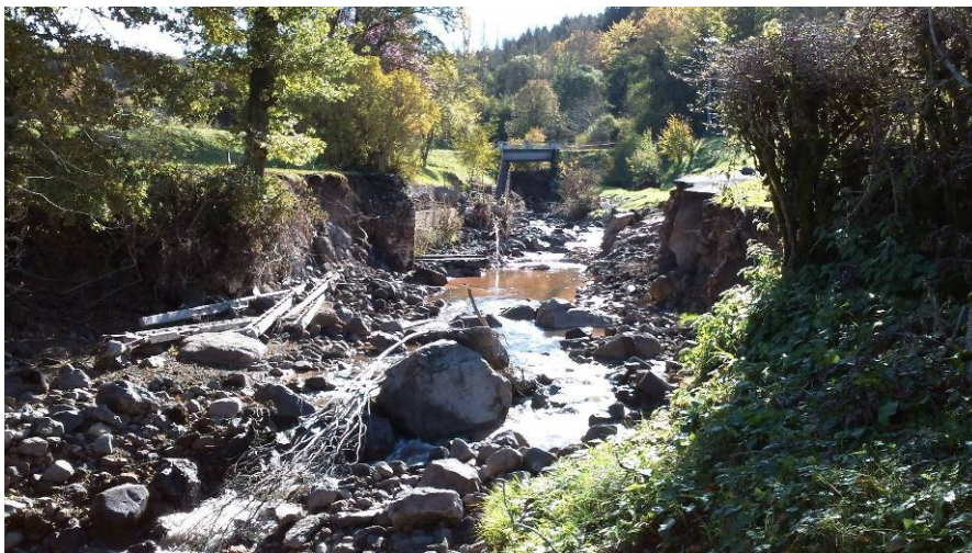
La Sionne au moulin de Drugeac, dégâts de la crue du 31/08/2011 (Photo : Th. PANTAROTTO. ONEMA, SD 15)
