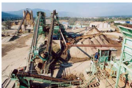
Installation de traitement des matériaux
