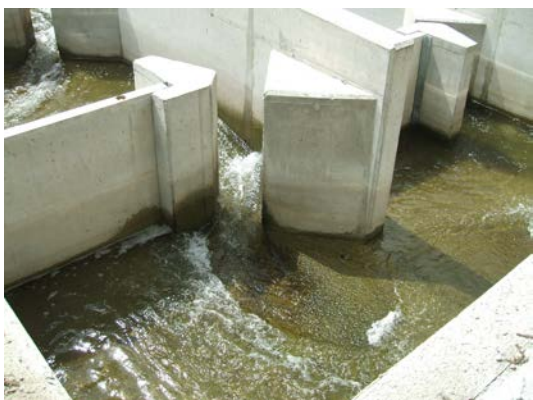
Détail de la passe à poissons (à gauche) et de la passe à anguilles (à droite)
