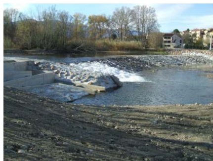
Seuil du Boulou
