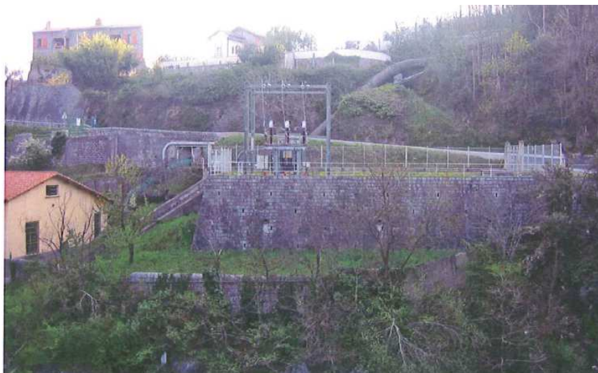
Micro-centrale hydro-électrique au Pas du Loup
