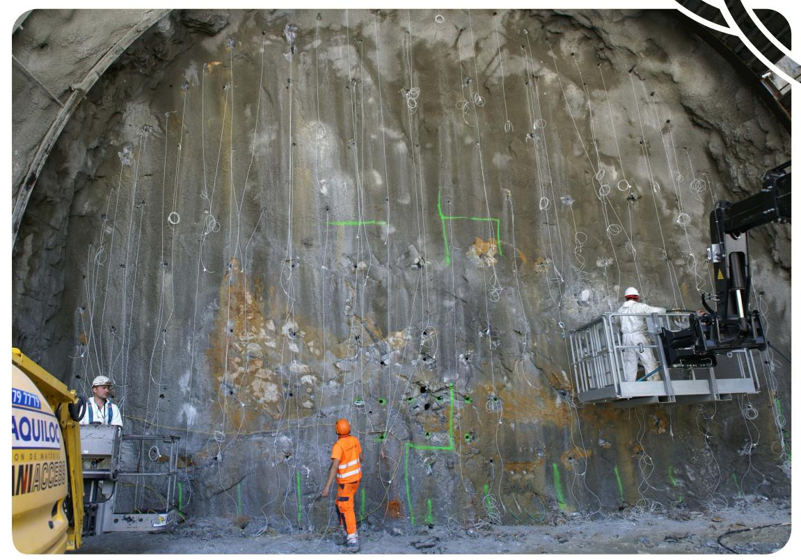
2- Le chargement de chaque trou avec une émulsion explosive type MORSE® par des artificiers.
