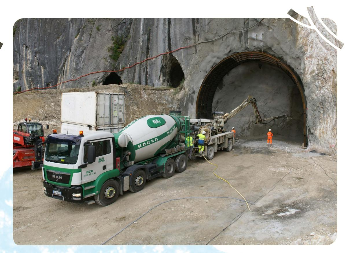
6- La sécurisation de la voûte par purge pour enlever les blocs instables puis consolidation de la voûte par du béton projeté et si besoin par des ancrages ou des soutènements.
