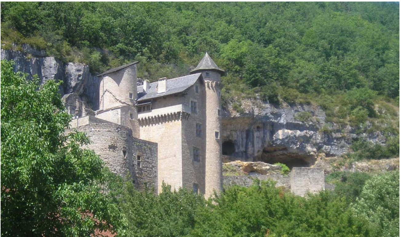
Vue globale du château de Larroque-Toirac
