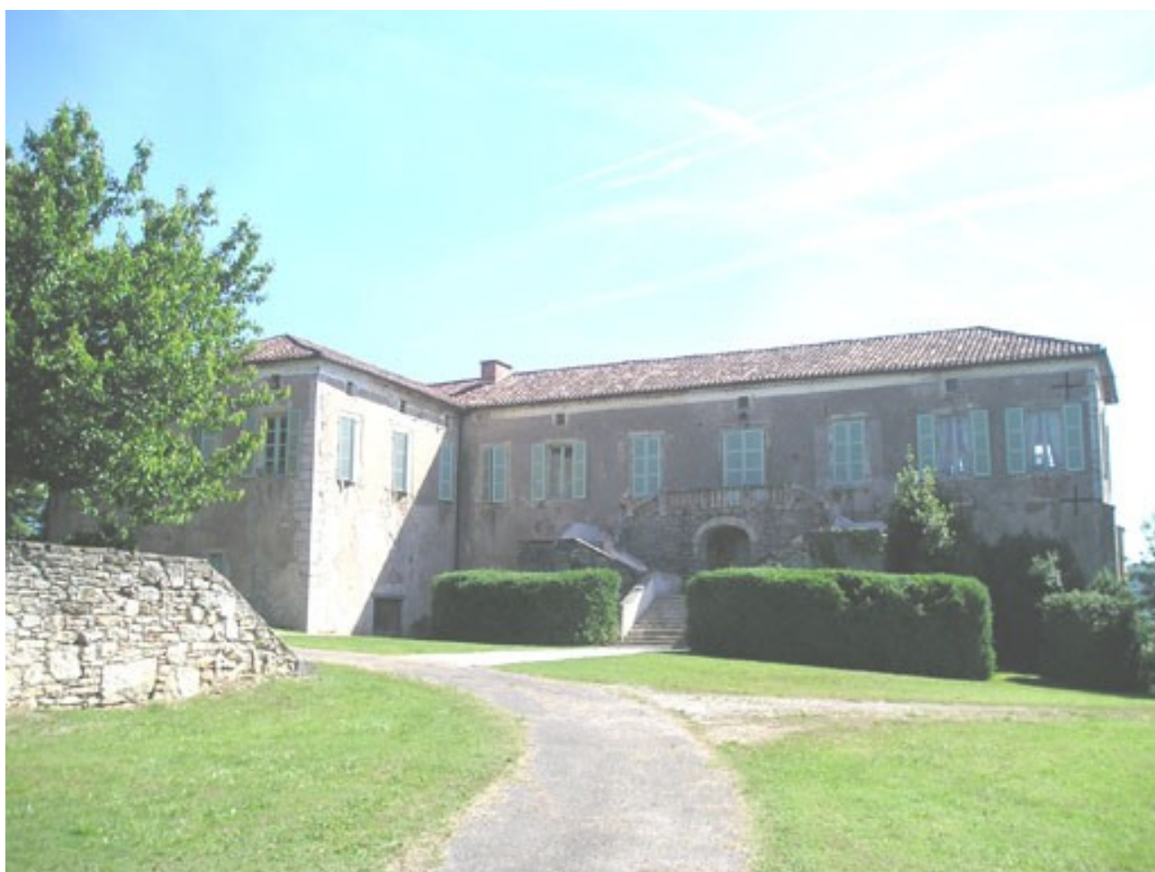
Façade Ouest du château.
