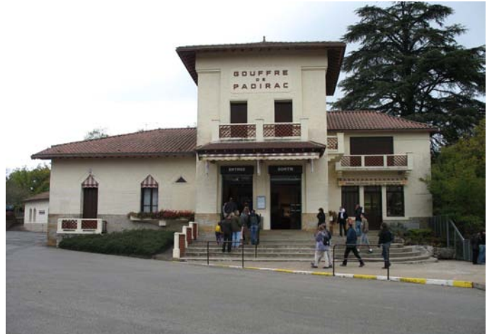
Le bâtiment d'accès au gouffre à l'architecture typique des années 1930
