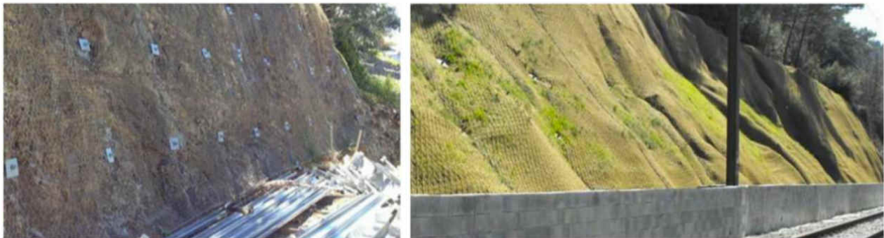
Figure 11 : Exemples de confortement par filet cloué (à gauche) et par géonatte (à droite)
