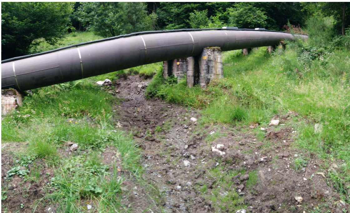
Figure 7 : exemple d'une zone de ravinement (ici au niveau de P23)
