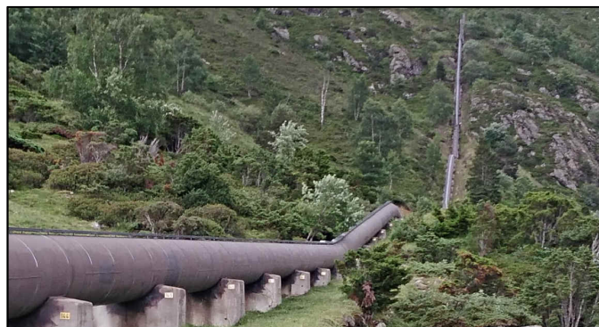
Figure 31 : Lande en cours de fermeture de part et d'autre de la conduite forcée
