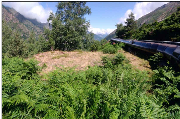
Figure 25 : Exemple de plateforme de marinage
