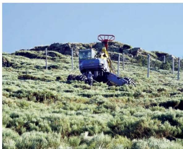
Travaux d'installation de systèmes paravalanches à Porté-Puymorens (août-novembre 2018) ©SAPYRA 2017
