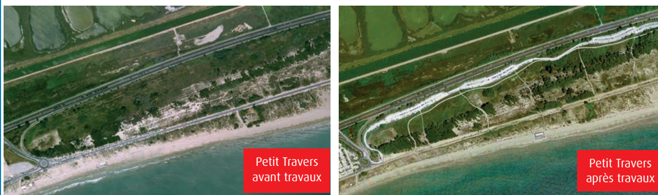
Figure 26 : Aménagement du lido du Petit Travers - Projet Adapto © Conservatoire du littoral
