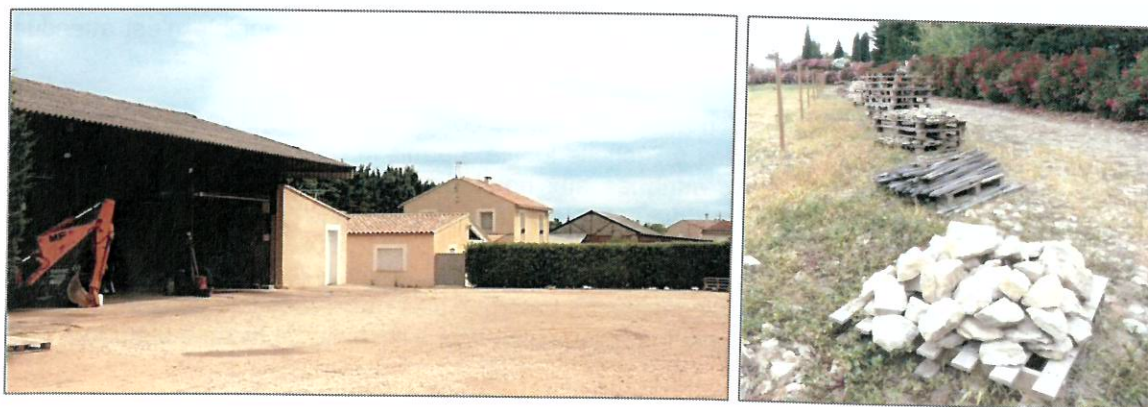
Aperçu des bâtiments et zones de dépôts présents sur site – CBE, 12 juillet 2016
