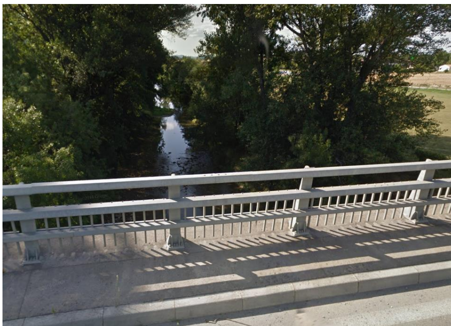
Illustration 4 : Photographies du Vidourle au droit du pont sur la RD45 à Quissac
