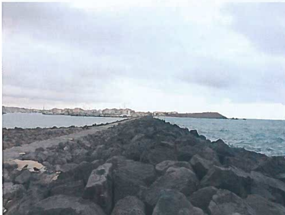
Photo n°3 : Digue principale du port (24/04/17)
