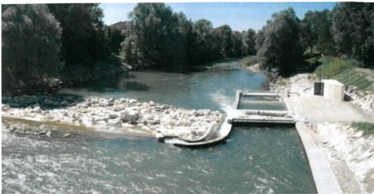
Figure 1 : Exemple d'un projet hydroélectrique basse chute type VLH
