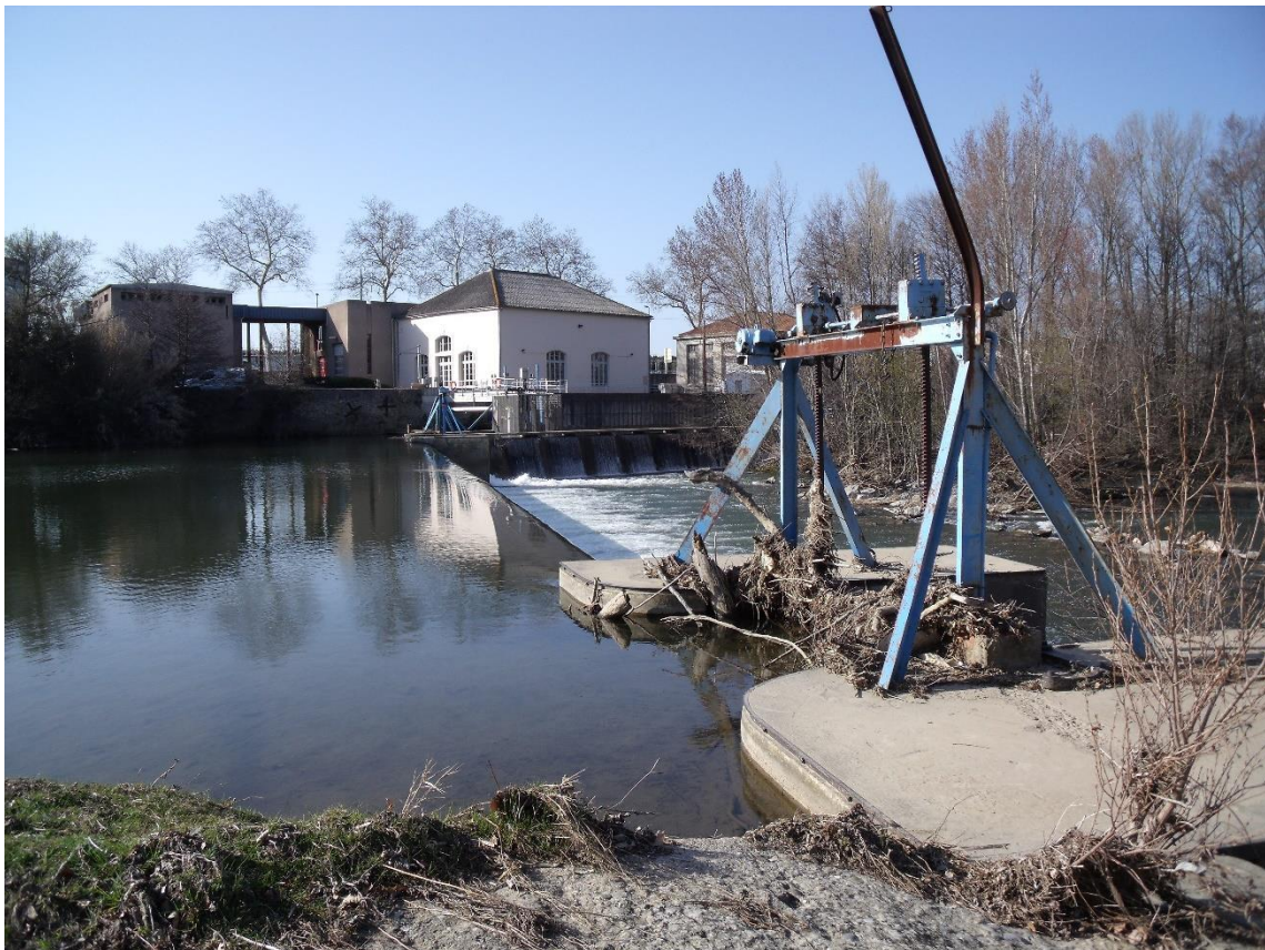
Prise de Maquens et station de potabilisation - Vue depuis la rive droite de l'Aude
