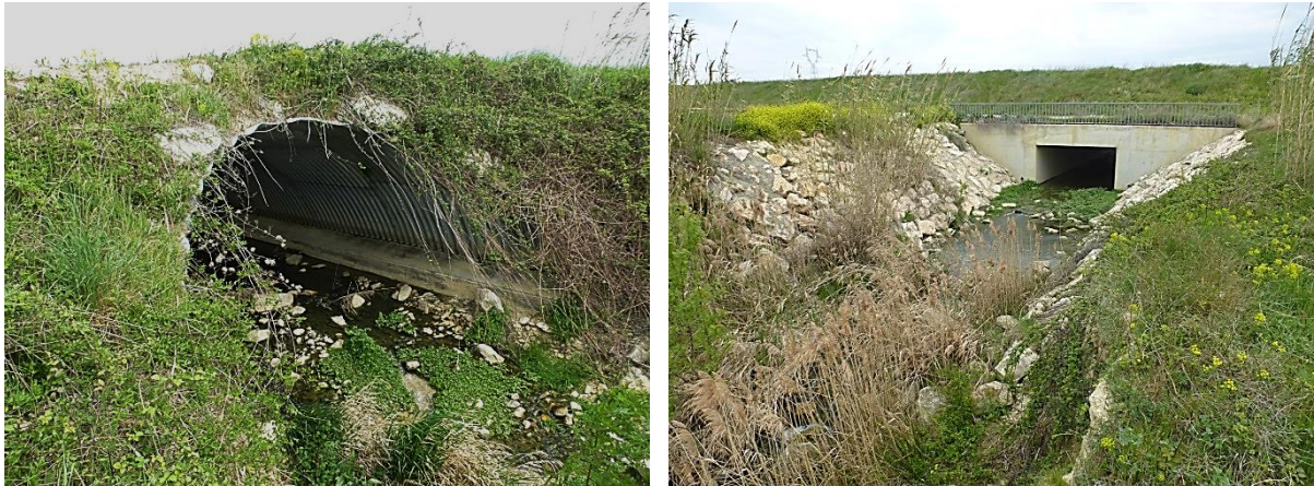
Illustrations d'ouvrages d'art prospectés sur de l'aire d'étude - Photo sur site
