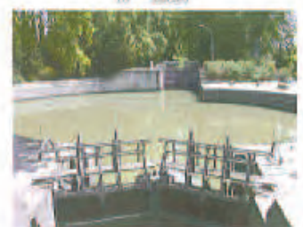
Écluse et pont à la Garonne (modification Poyssonier) (20 ème siècle)
