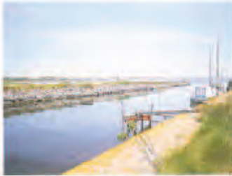
Reinforcement de berge par béton
