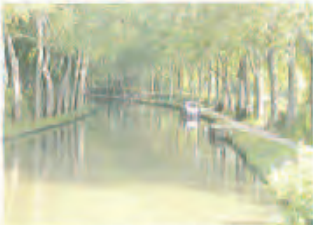
Alignement au gabarit aux abords de l'écluse de Fricourt
