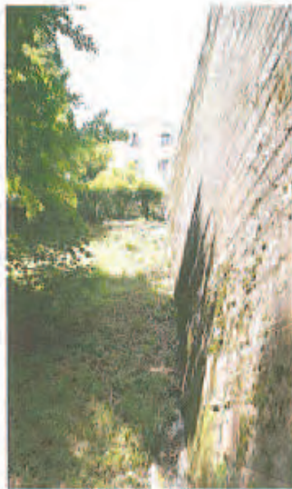
Le barrage de Saint-Florent
