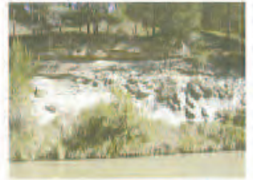
Reinforcement de berge par béton
