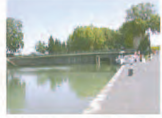
Pont de pont d'Argle (ancien) - 1900 - 1900 (ancien)
