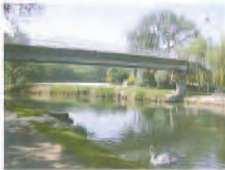
Pont de la Vallée à Castelnau
