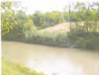
Reinforcement de berge par béton
