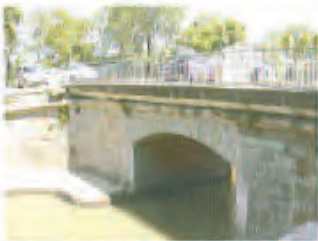
Pont ancien sur le canal de Saint-Jean à Castelnau
