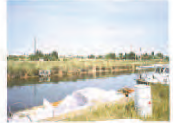
Reinforcement de berge par béton
