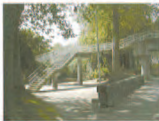
Pont de la Vallée à Castelnau
