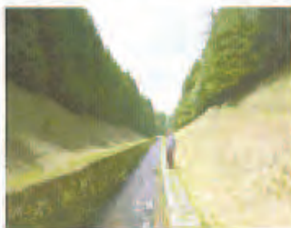
Le barrage de Saint-Florent
