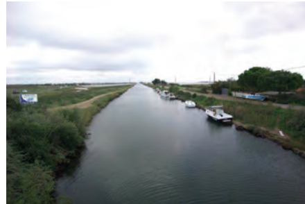
Débouché du Canal dans l'étang de Thau à Marseillan
