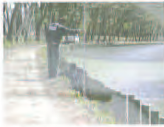
Reinforcement de berge par béton
