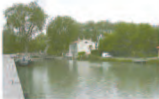
Ensemble port (eau) ancien restauré à Gardouch
