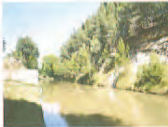
Reinforcement de berge par béton
