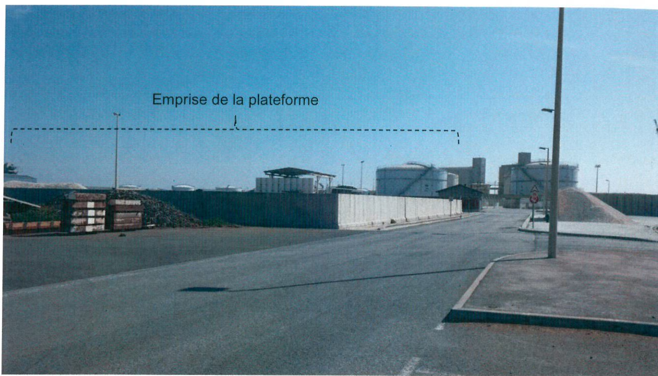
Les profilés béton masquent la plateforme Etablissement DYNEFF en arrière-plan
