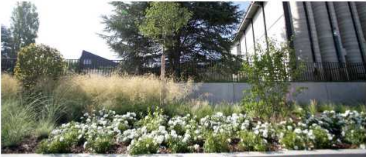
Traitement paysager du talus en pied de mur de soutènement en béton brut - ZAC de la chancellerie Bourges - D.Paysage
