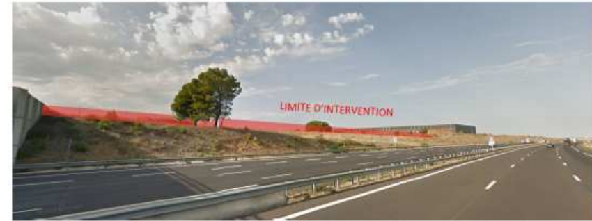
Talus existant - Vue depuis l'autoroute - Septembre 2014 - Google map
