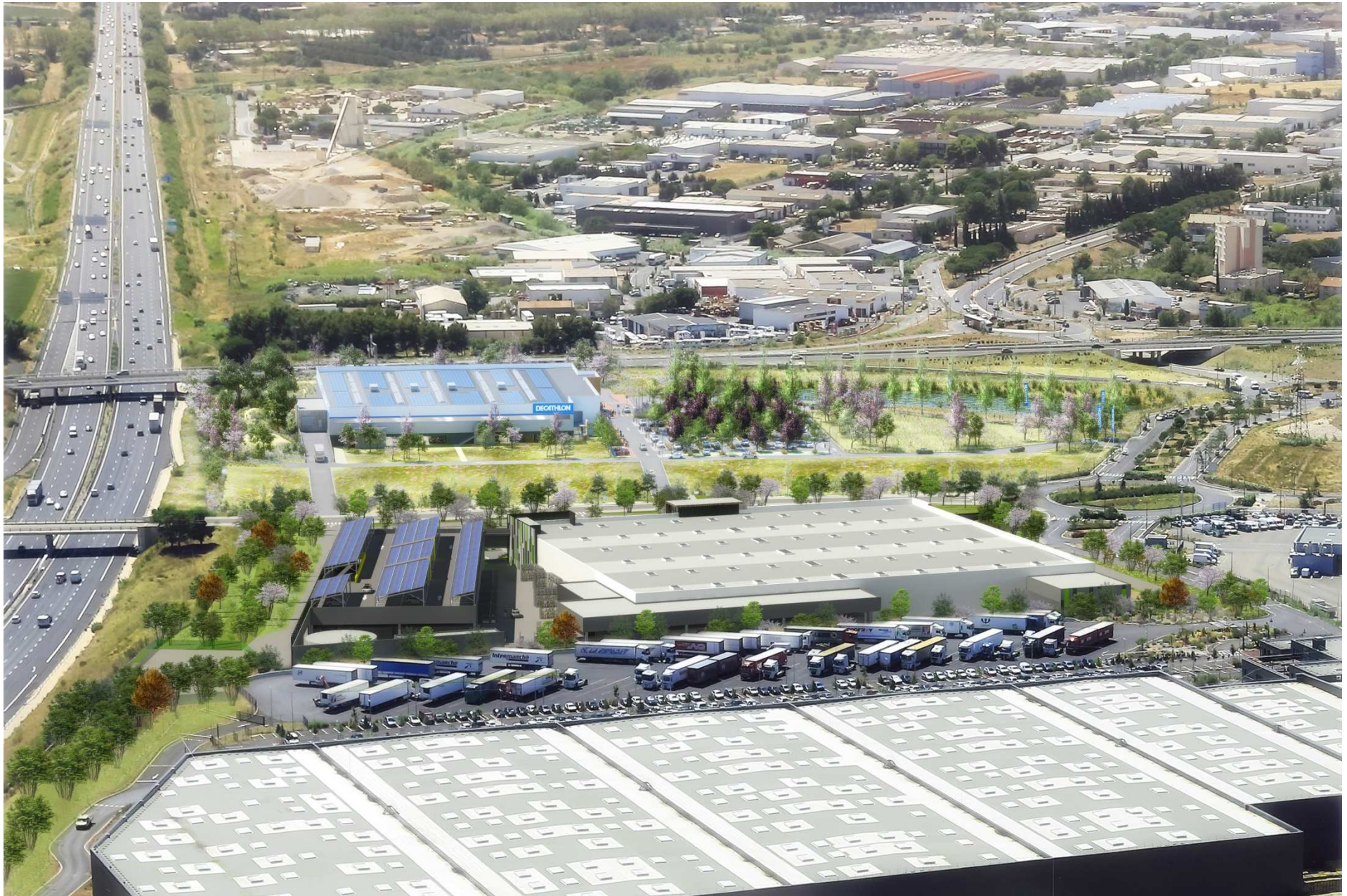
Vue aérienne du projet depuis l'entrepôt logistique et son parking PL au nord-ouest du site
