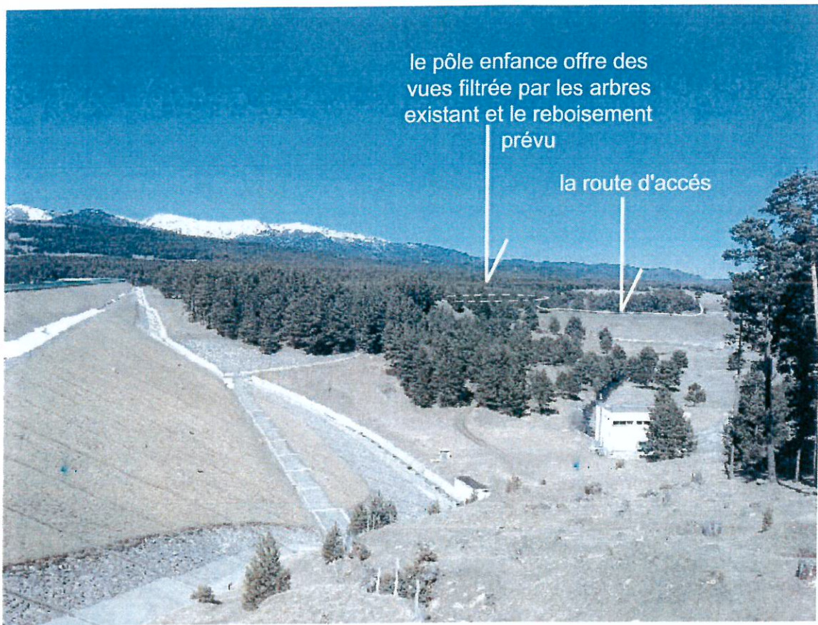
photo 2 : vue depuis la RD , en direction de Matemale en venant de la Llagone, au niveau du barrage : le site est situé en contrebas du barrage, à une distance supérieure de 300m de celui-ci.
