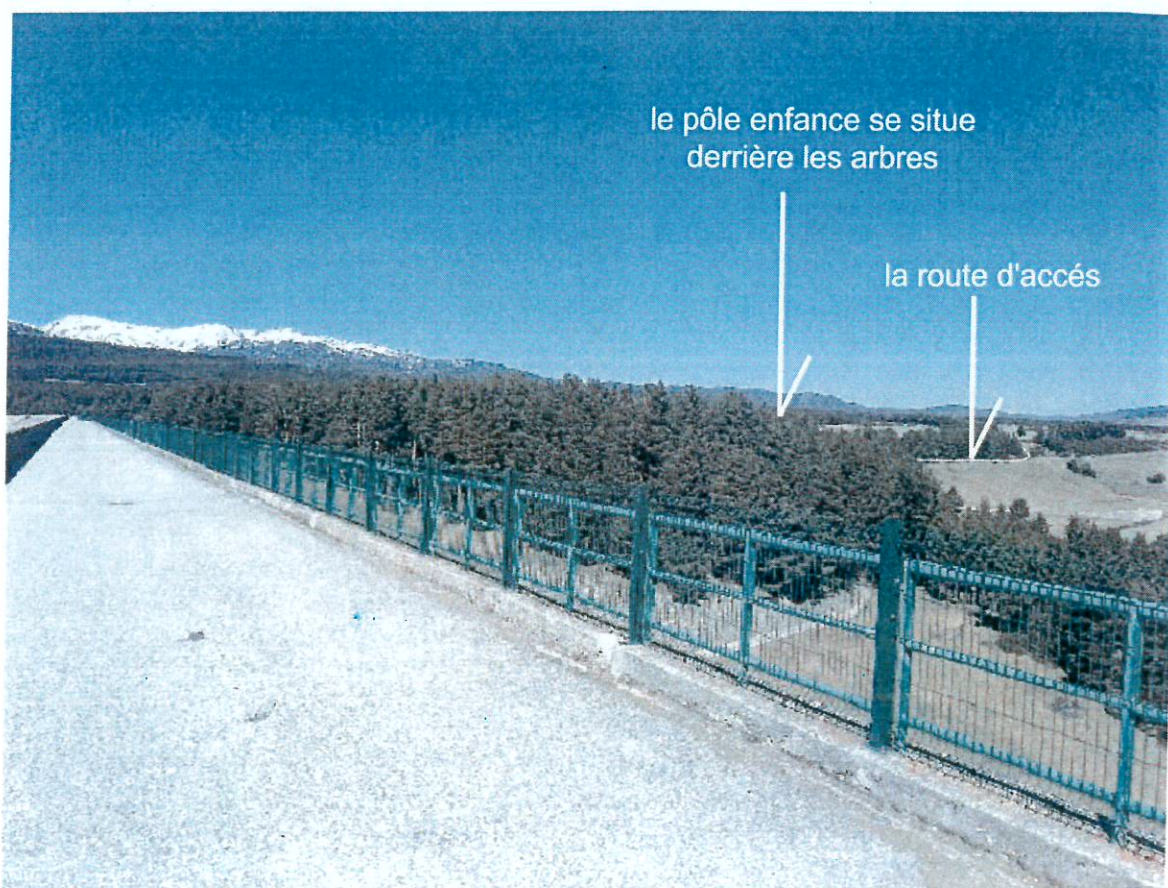
photo 4: pied sur l'ensemble du barrage, le site est complètement caché
