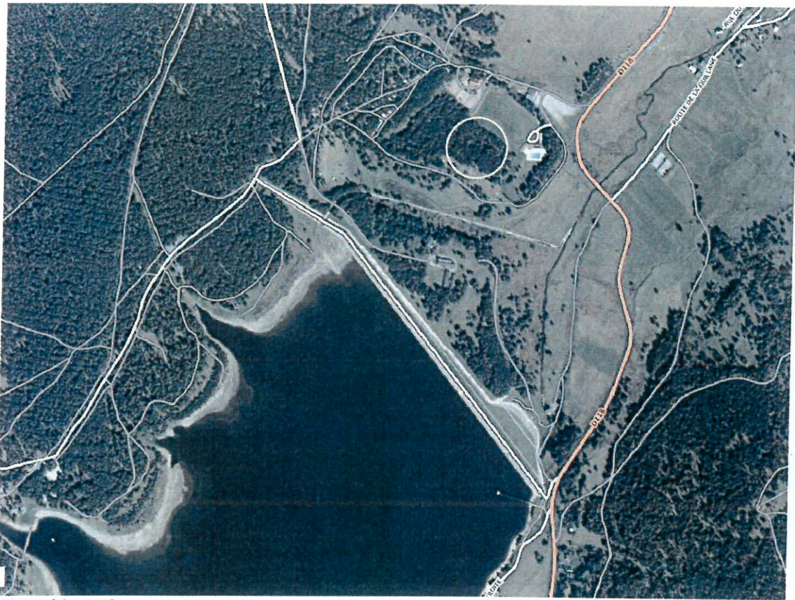
Vue aérienne 2 Le site : proche du stade et la piscine
