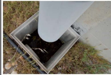
Figure 51 : gouttières actuelles autour des réservoirs
