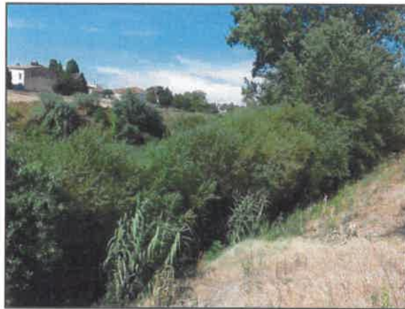
Secteur concerné par un confortement de berge et replanté avec des fascines de Saule
