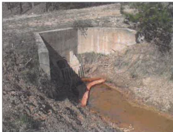
Exemple d'utilisation d'un boudin dédié à l'absorption des hydrocarbures
