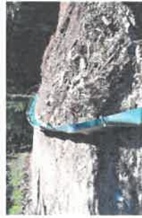
Photo 30 : Bâche anti-intrusion (at-bv03-17)
