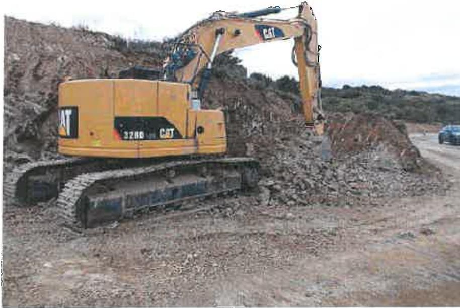
Photographie : Pelleuse à l'amât à l'avancement de la découpe du front de taille
