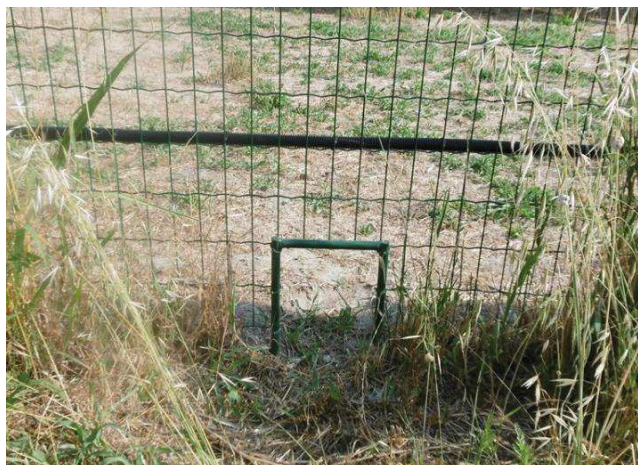
Exemples de passages à petite faune à prévoir lors de l'installation des clôtures : à gauche, silhouette en tôle permettant le découpage de la clôture (Agence Rhizome) ; à droite, ouverture incluse dans la clôture (CBE, 2017)
