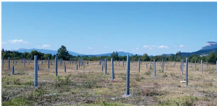
Vue d'une centrale en tracker en cours de construction – Pieux battus
