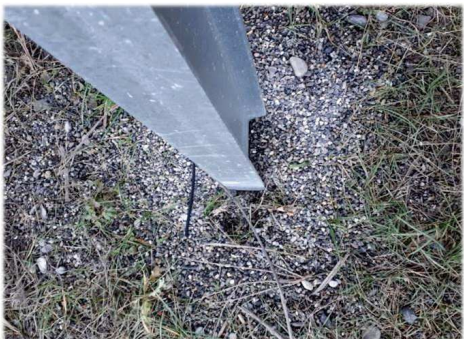
Vue d'un pieu battu
