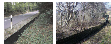
Exemple de dispositif : plaques rigides (à gauche) et bâche souple (à droite)
