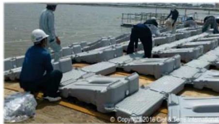
Exemple d'assemblage sur plateforme de lancement (© Ciet & Terre)
