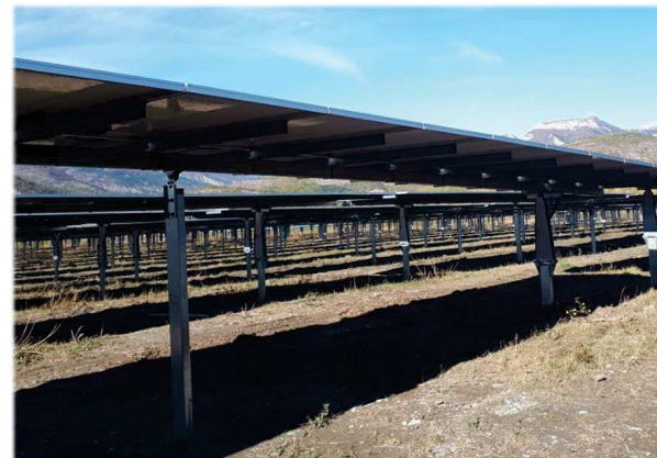
Vue avec les panneaux installés
