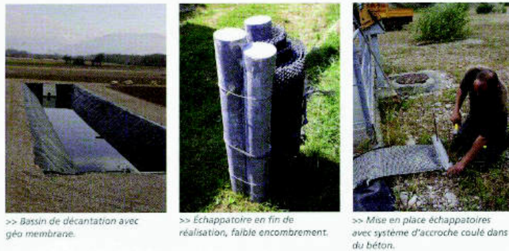
Exemple de dispositifs permettant à la faune de sortir des bassins (source : conseil général d'Isère)
