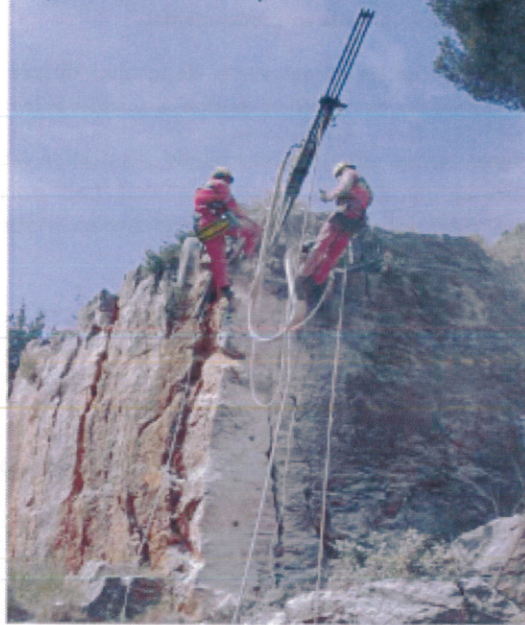
Illustration foreuse de type CEI (marteau hors trou)
