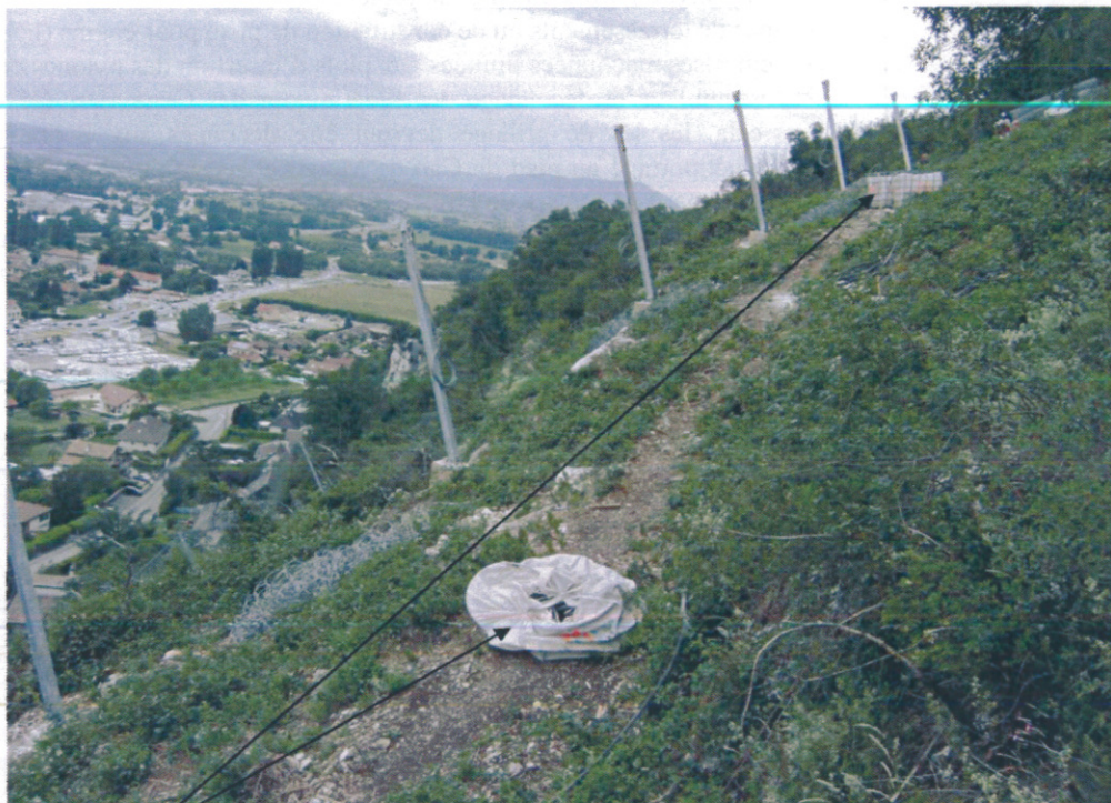
Exemple de terrassement nécessaire pour le stockage du matériel
