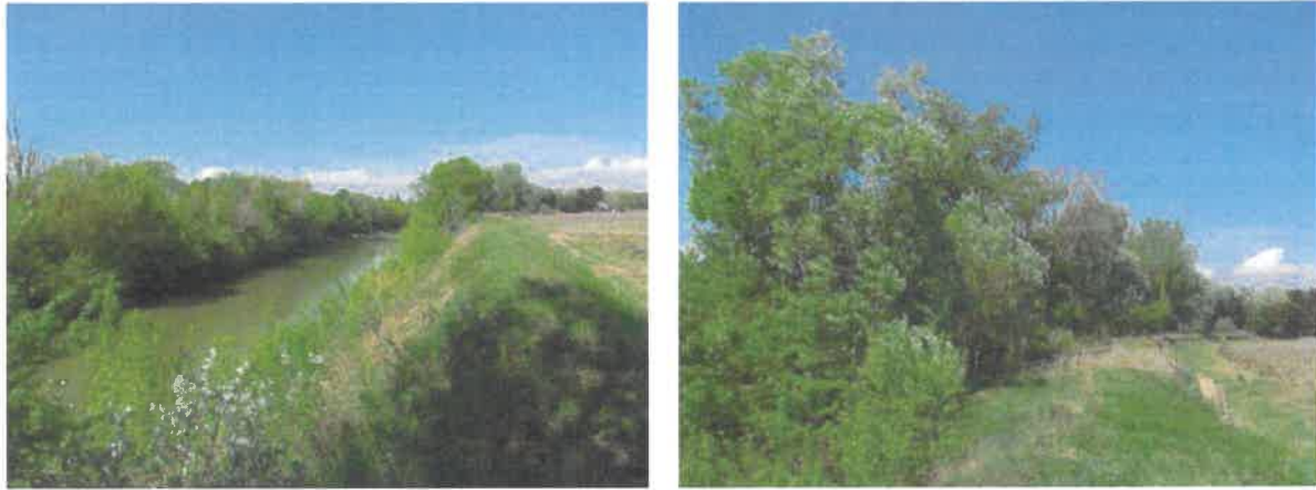
Dignes dénudées et ripisylves non touchées par les travaux au niveau de Blanche Fougasse
