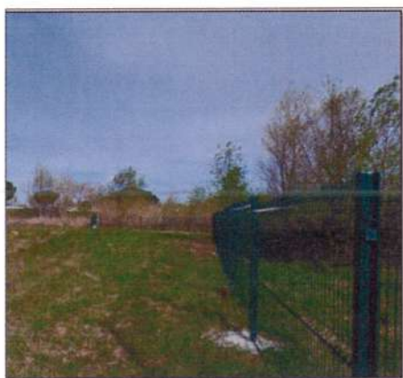
Clôture rigide isolant la station de reproduction de la Diane du chantier de rocade
