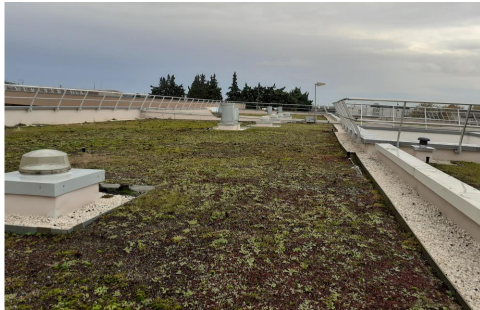
Toiture végétalisée administration en hiver
