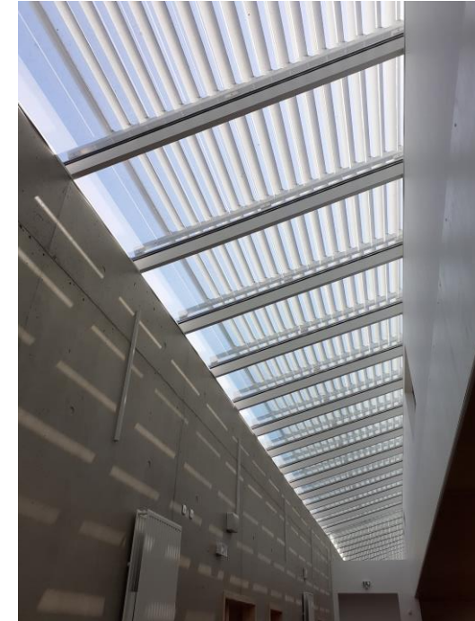
Efficacité des brise-soleils de la rue centrale au mois de juillet
