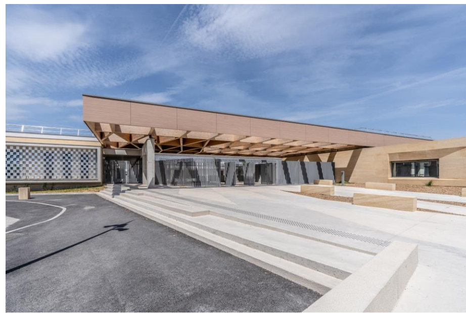
Façade Sud Parvis
