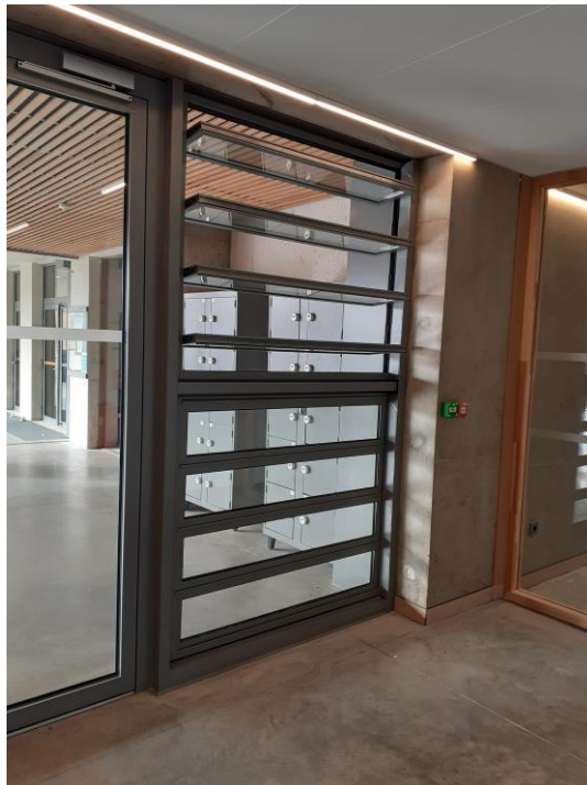
Châssis RDC Sud - entrée
