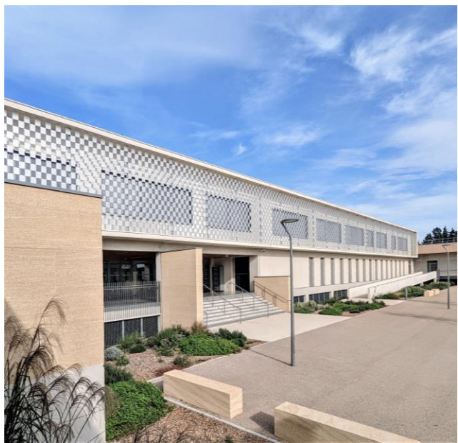
Façade Sud sur Cour
