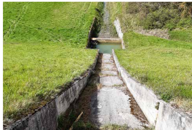
Évacuateur de crue du barrage de Saint-Cricq photo DREAL Occitanie
