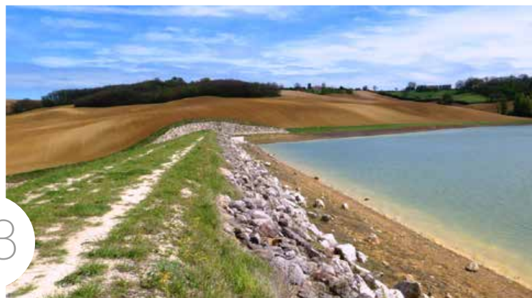
Crête du barrage de Bouillac photos DREAL Occitanie
