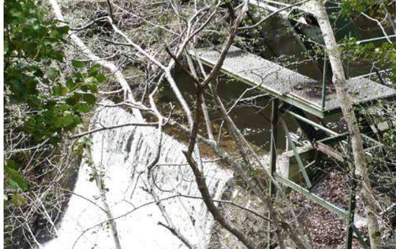
Aménagement hydroélectrique de Miraval photo DREAL Occitanie
