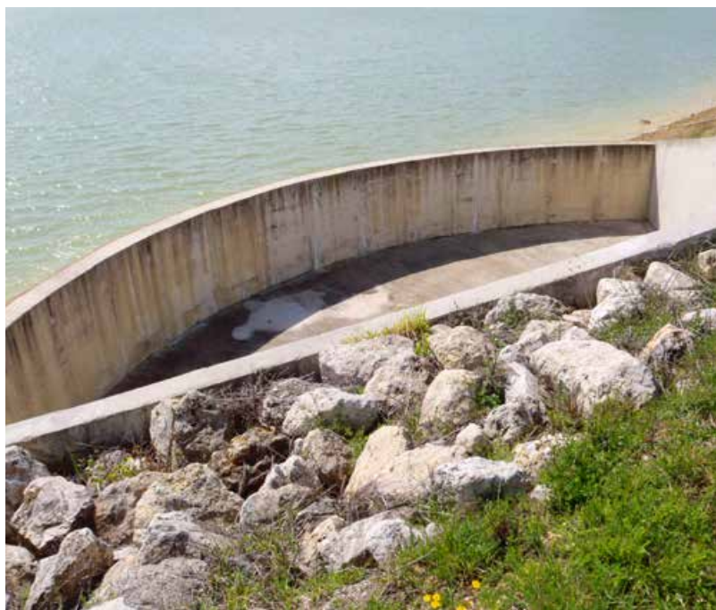
Déversoir du barrage de Bouillac photos DREAL Occitanie
