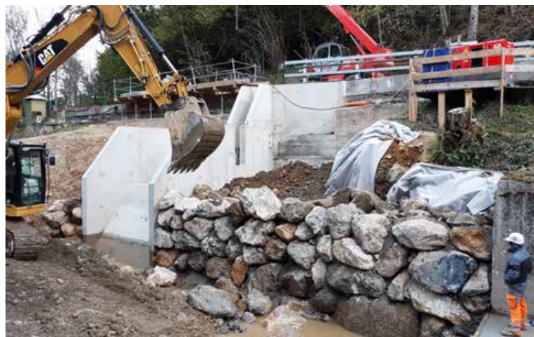
Barrage de Campan photo DREAL Occitanie
