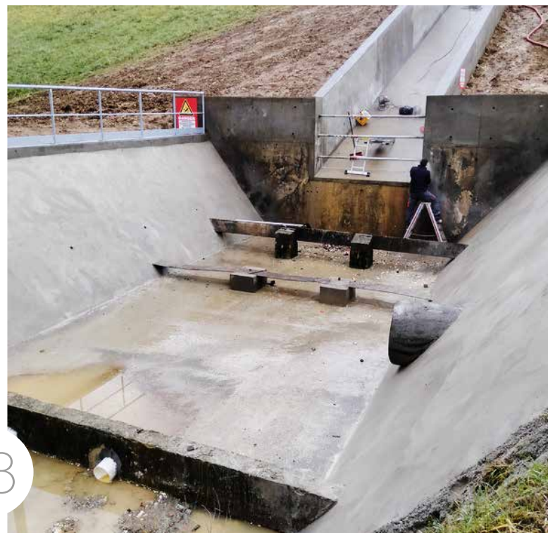
Nouvelle aménagement du barrage de Saint-Jean photo DREAL Occitanie
