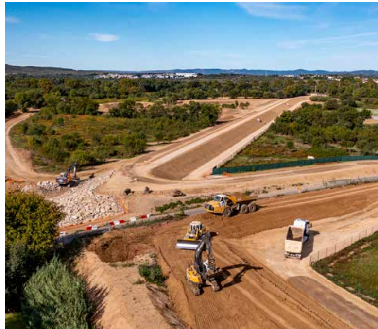
Chantier de la digue de Mosson photo Montpellier Méditerranée Métropole
