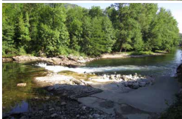
En 1993, avant réfection du seuil de Bompas, photo EDF
