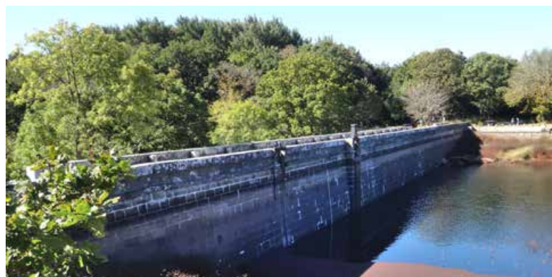
Barrage de Saint-Denis aval photo DREAL Occitanie
