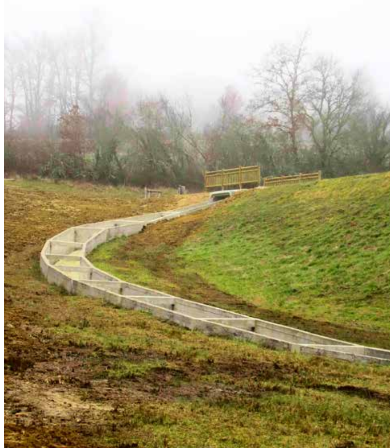
Évacuateur de crues du barrage de Malivert après travaux photos DREAL Occitanie
