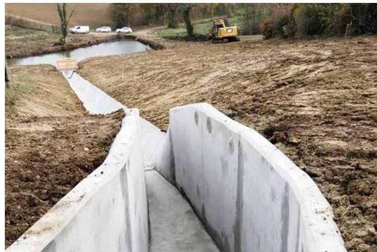
Évacuateur de crue du barrage d'Escalavès photo DREAL Occitanie
