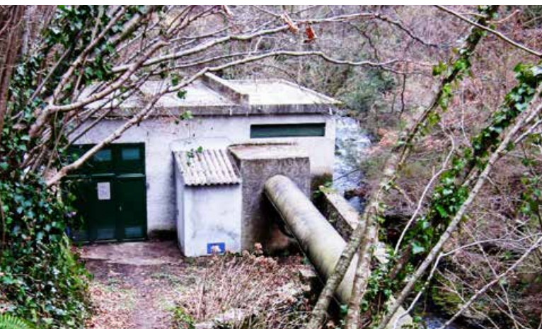
Aménagement hydroélectrique de Miraval photo DREAL Occitanie
