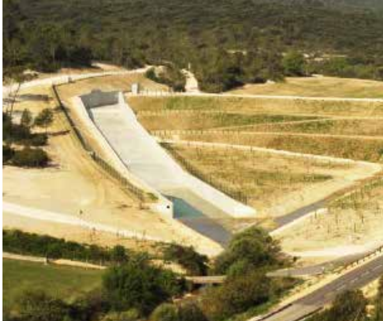
Vue aval du barrage de Saint-Geniès -de-Malgoirès photo EPTB Gardons
