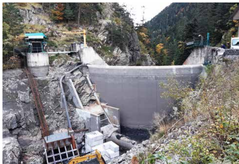
Barrage du Rioumajou photo DREAL Occitanie
