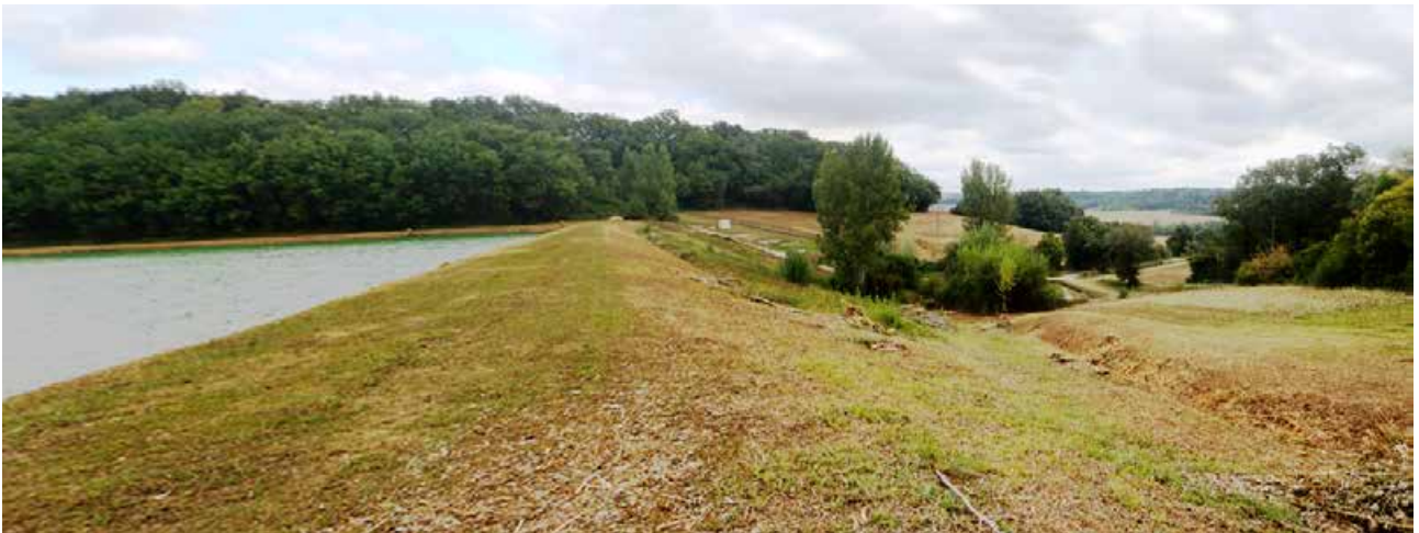
Barrage d'Escalavès avant aménagement de l'évacuateur de crues photo DREAL Occitanie
