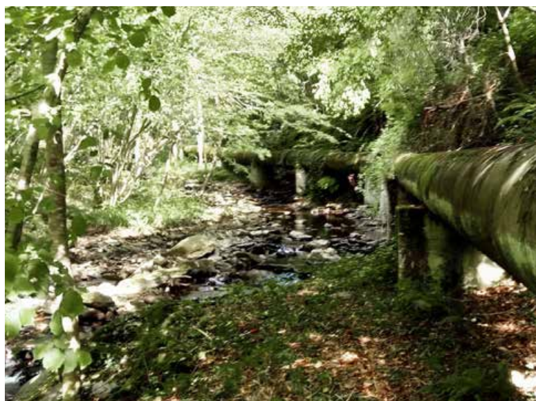
Aménagement hydroélectrique de Miraval photo DREAL Occitanie
