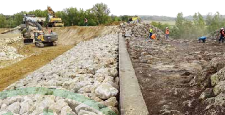
Barrage de Bouillac en cours de travaux - photo DREAL Occitanie
