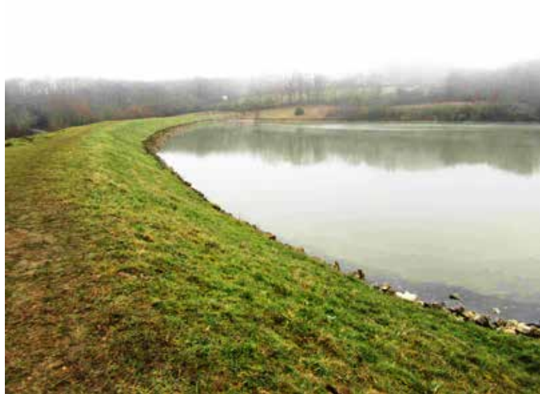
Barrage de Malivert à Molières (Tarn-et-Garonne) - photo DREAL Occitanie
