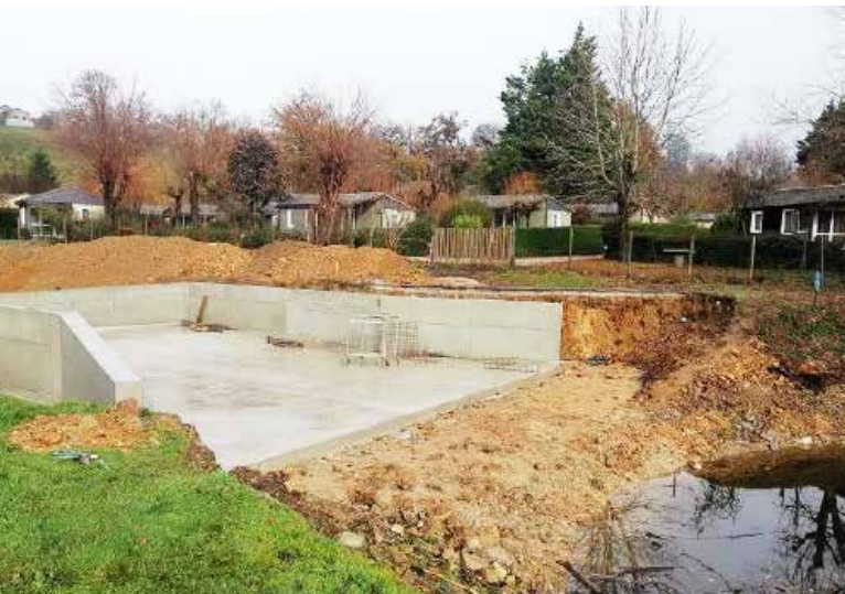
Évacuateur de crue du barrage de la Prade en cours de modification photo AGERIN
