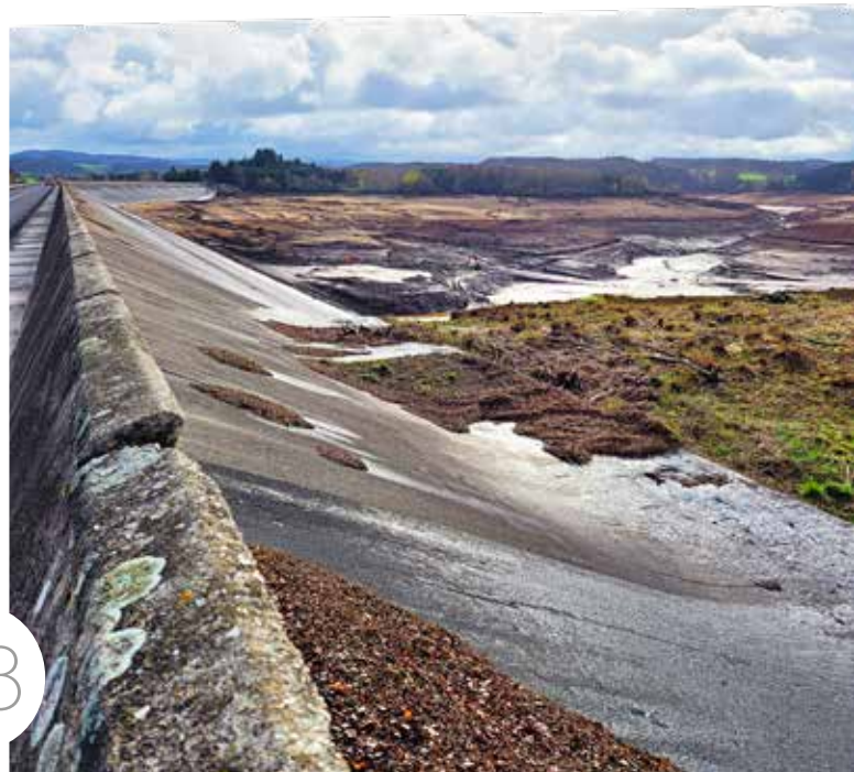
Barrage amont de Montézic - photo DREAL Occitanie
