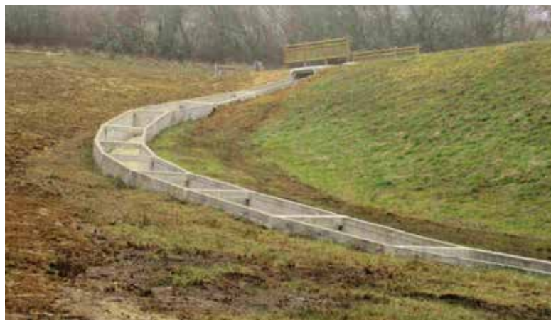
Évacuateur de crue du barrage de Malivert après réfection - photo DREAL Occitanie
