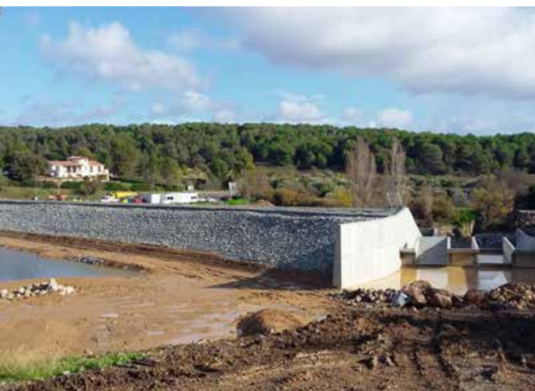
Barrage de Ruchol, en cours de travaux - photo DREAL Occitanie
