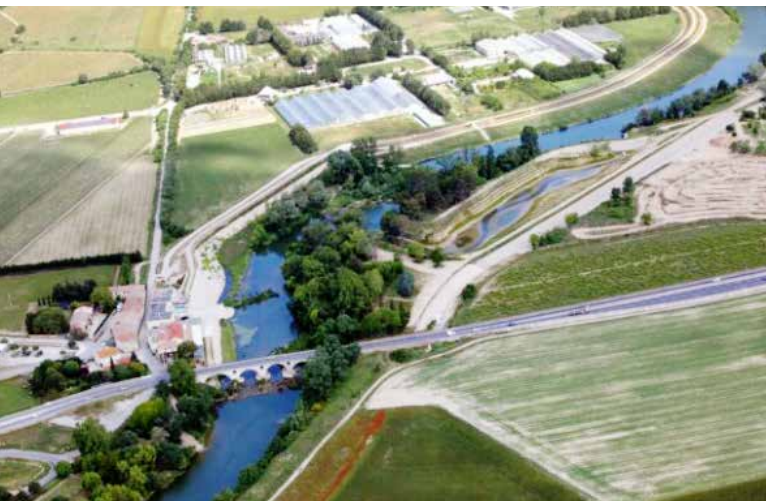
Digue du Vidourle, entre Lunel et Gallargues (Hérault) - photo EPTB Vidourle
