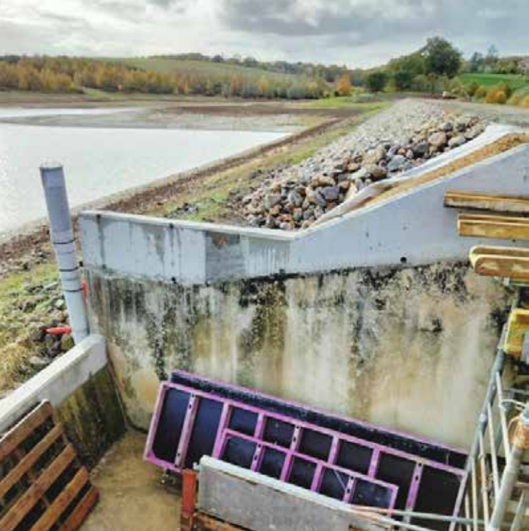
Barrage du Lizet en phase de travaux (oct. 2022) - photo DREAL Occitanie
