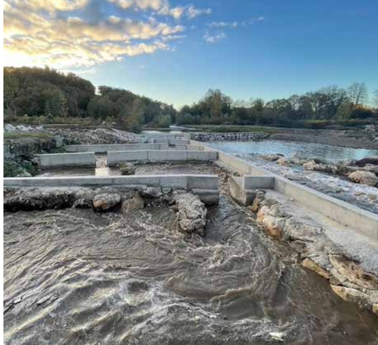
Barrage et passe à poissons de Salies-du-Salat (Haute-Garonne) - photo Ugo ingénierie
