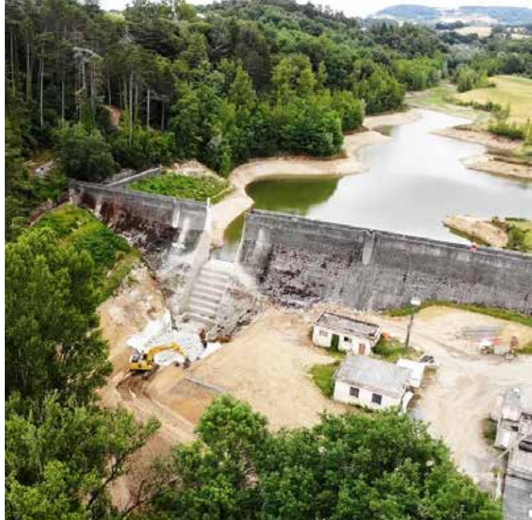
Barrage de Miquelou après modification - photo Mairie de Graulhet
