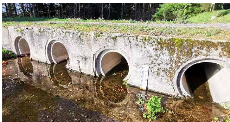
Évacuateur de crue du barrage de la Prade photo AGERIN
