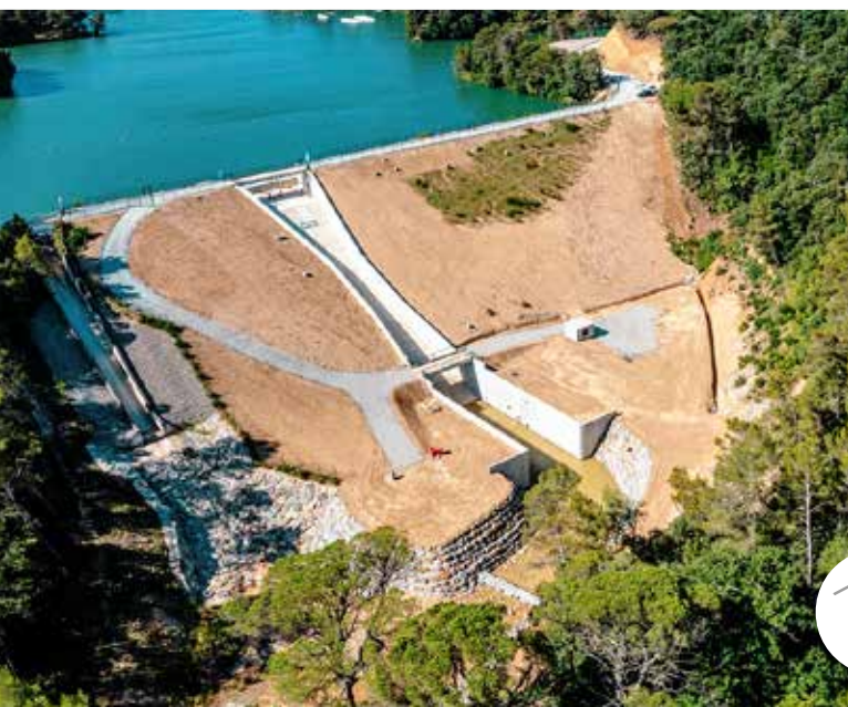
Barrage de Cavayère après travaux - photo Carcassonne Agglomération
