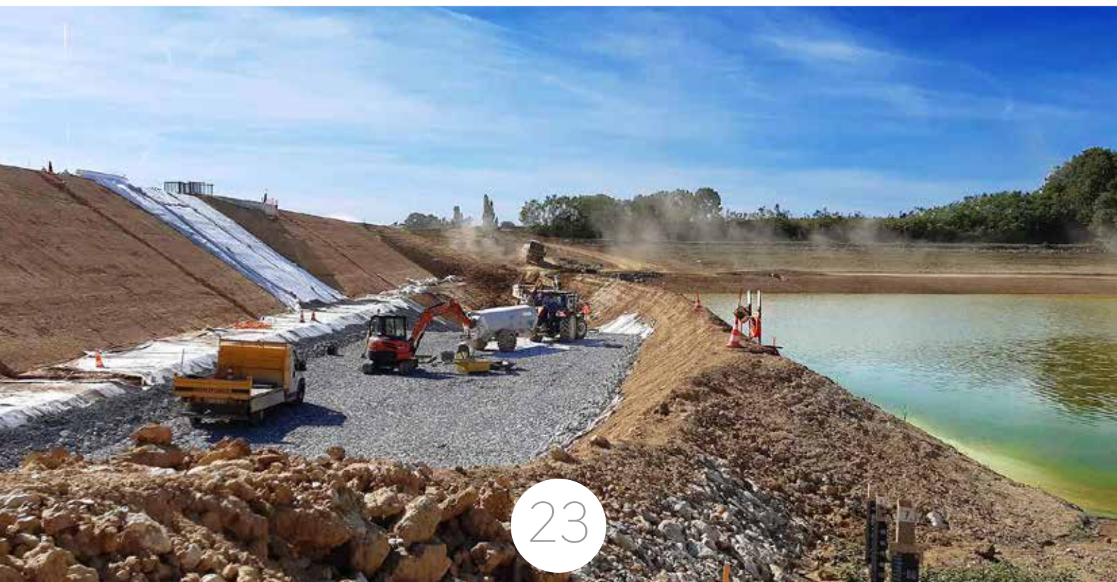
Barrage de Saclès en phase de travaux (sept. 2022) - photo DREAL Occitanie
