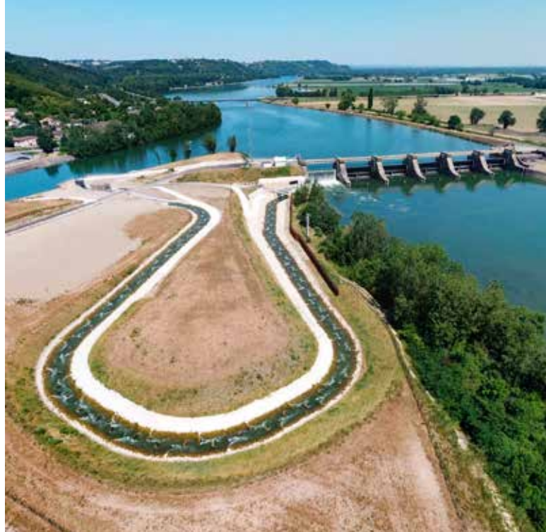
Rivière de détournement en service sur le barrage de Golfech (Tarn-et-Garonne) - Photo EDF
