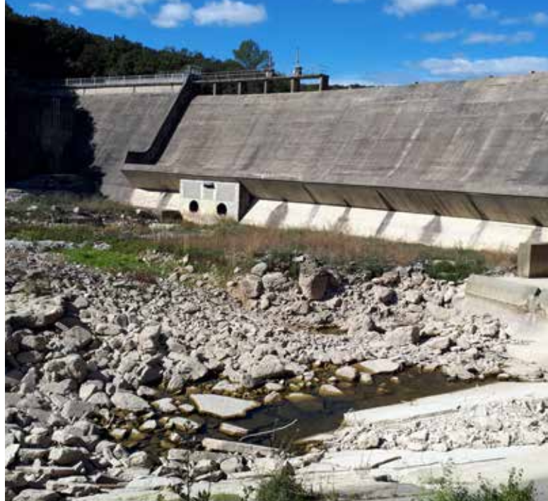
Barrage de Rouvière (Gard) - photo DREAL Occitanie
