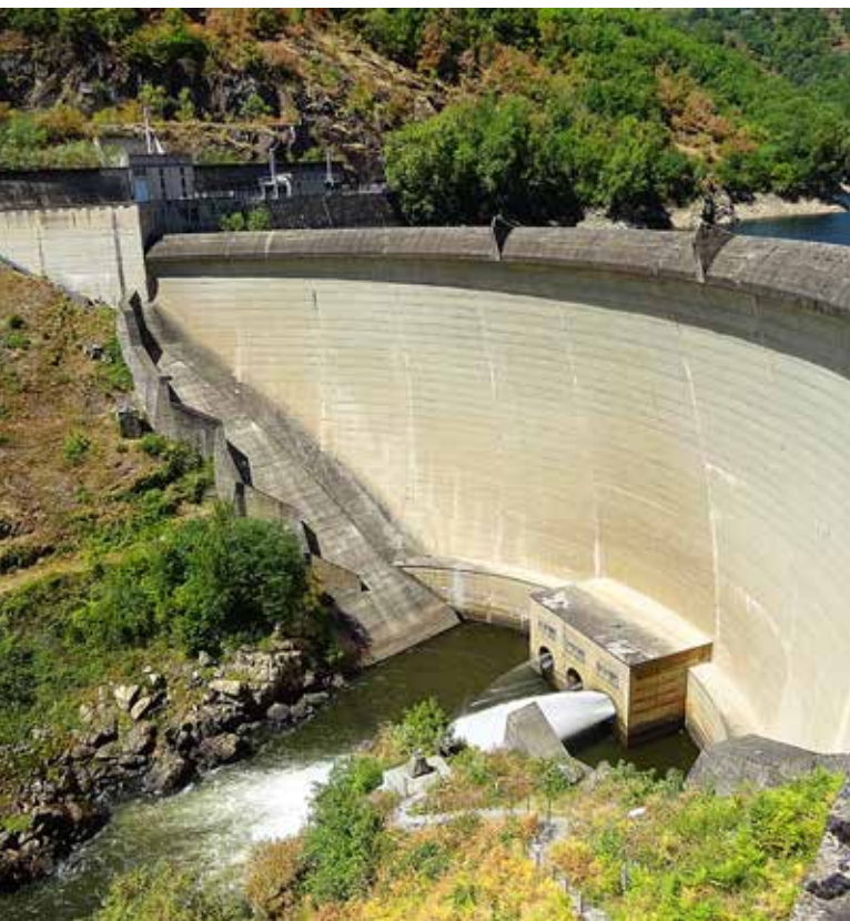
Voûte du barrage de Couesque, sur la Truyère photo DREAL Occitanie
