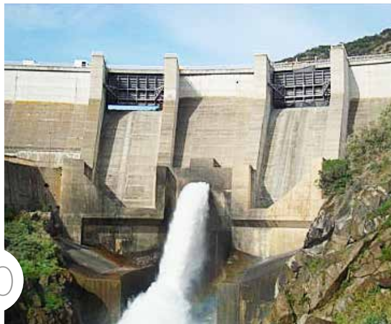
Barrage de Vinça (Pyrénées-Orientales) - photo DREAL Occitanie
