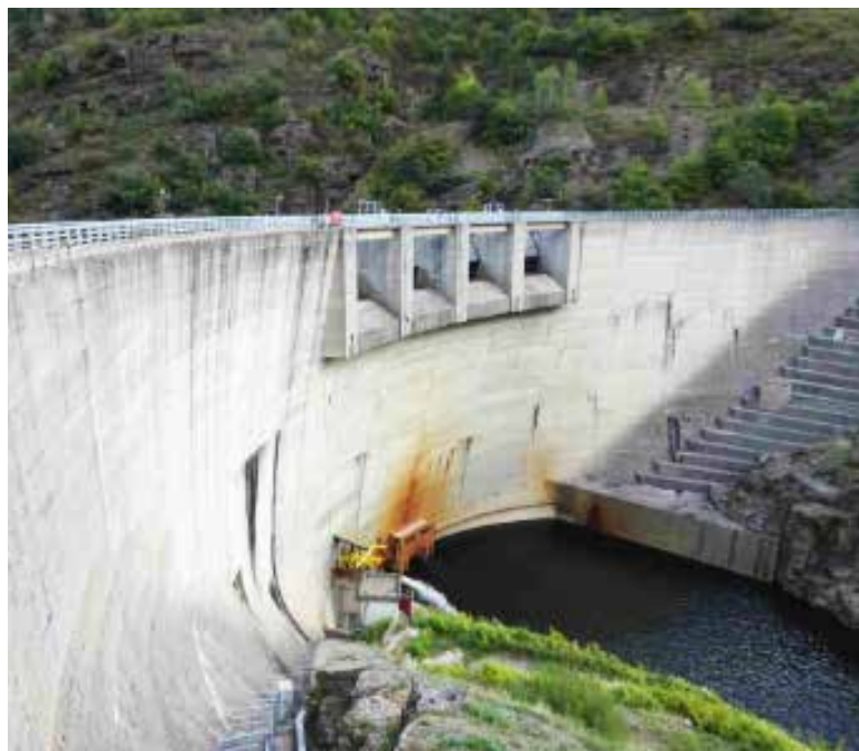
Parement aval du barrage de Roujanel (Lozère) - photo DREAL Occitanie
