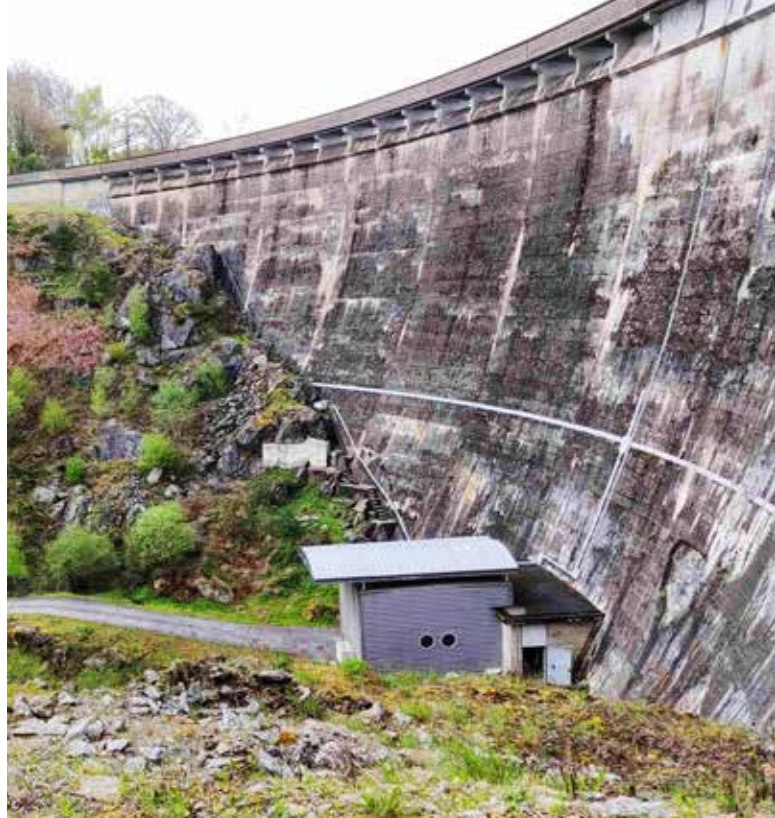
Barrage de Pareloup - photo DREAL Occitanie
