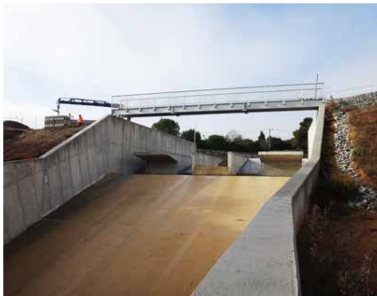
Déversoir PKW en aval du barrage de Ruchol - photo DREAL Occitanie
