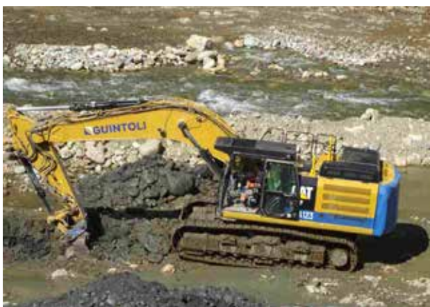
Pelle à l'œuvre à l'engagement du chantier du Mas del Rat (Hautes-Pyrénées) - photo DREAL Occitanie
