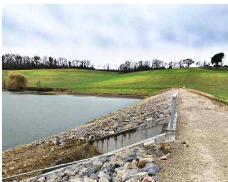
Barrage de Bousquetara après travaux (janvier 2025) - photo DREAL Occitanie
