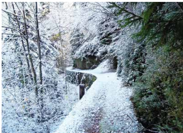
Canal carré dit l'Aqueduc de Marc - photo DDFIP
