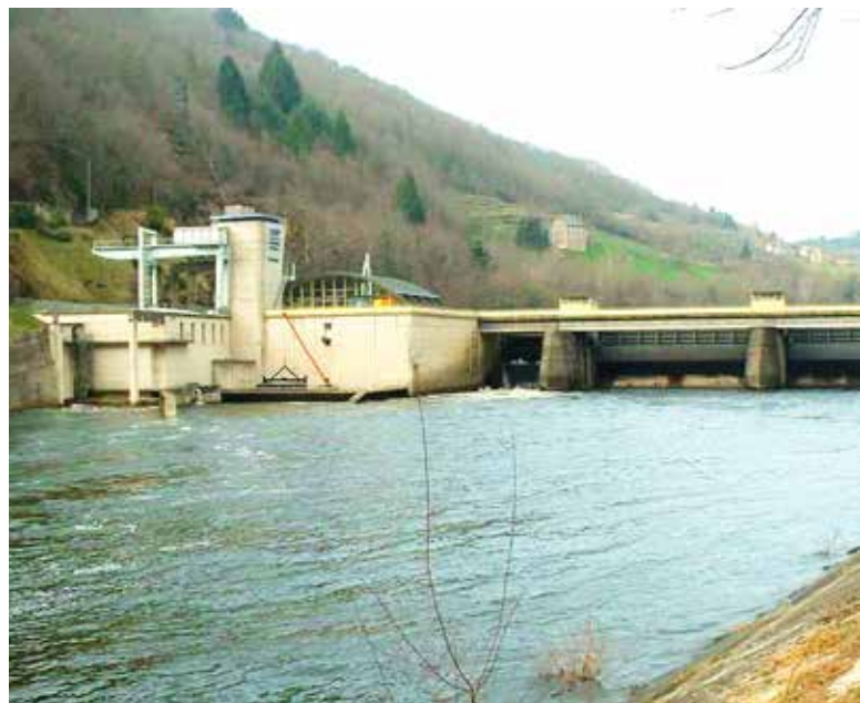
Barrage de Cambeyrac - photo EDF
