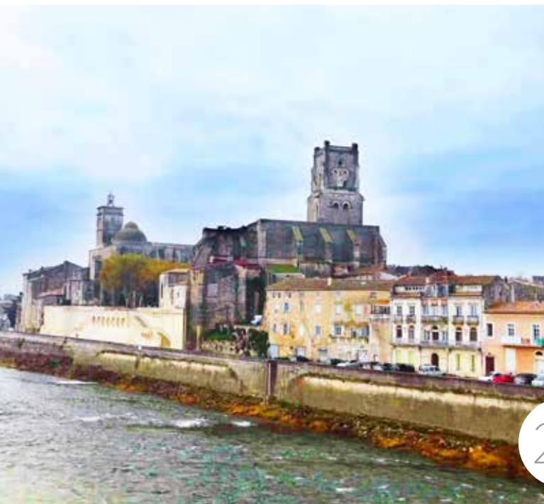
Digue du Rhône à Pont-Saint-Esprit (Gard) - photo DREAL Occitanie
