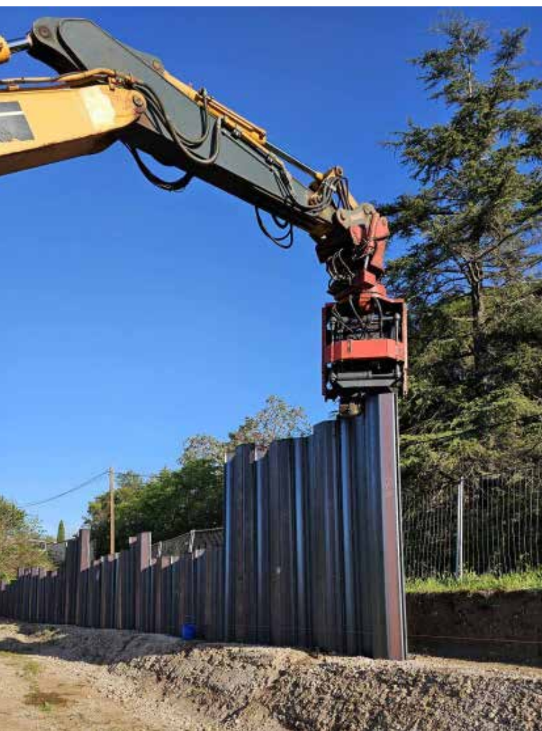
Palplanche en cours de mise en place (Hérault) - photo DREAL
