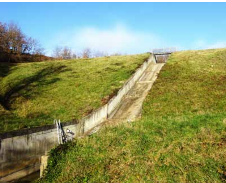
Barrage de Gaouzy - photo DREAL Occitanie
