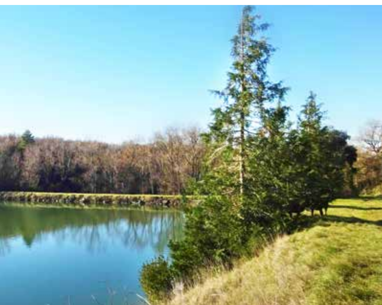
Barrage de Bajoffre à La Pomarède - photo DREAL Occitanie
