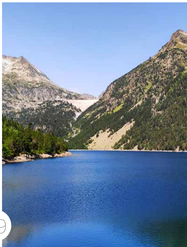
Retenue d'Orédon et barrage Cap-de-Long - photo DREAL Occitanie
