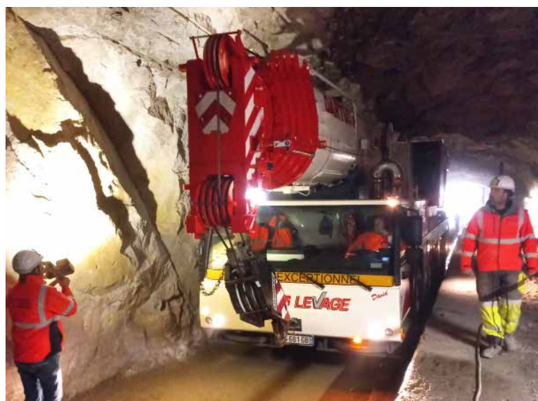
Fin des travaux d'agrandissement du tunnel d'accès avant la période sensible pour les chiroptères (début novembre 2024) - photo EDF
