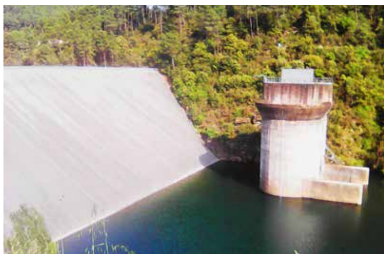
Parement amont du barrage de Sainte-Cécile-d'Andorge - photo DREAL Occitanie
