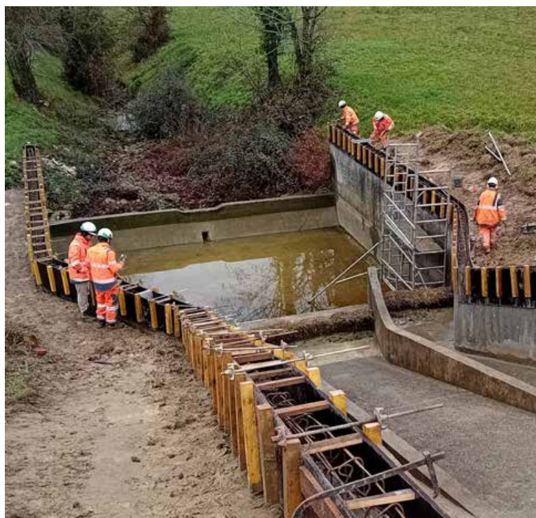
Évacuateur de crues du barrage de l'Uby en travaux - photo DREAL
