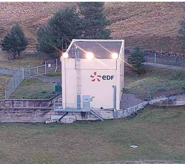
Spot lumineux éclairant le parement du barrage de Matemale – photo DREAL Occitanie
