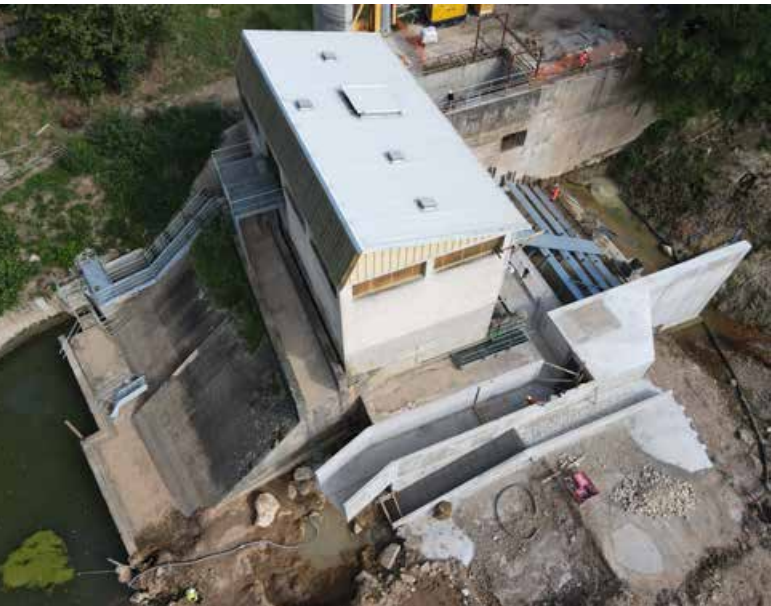
Prise d'eau de Lagarde – photo Ingé-eau
