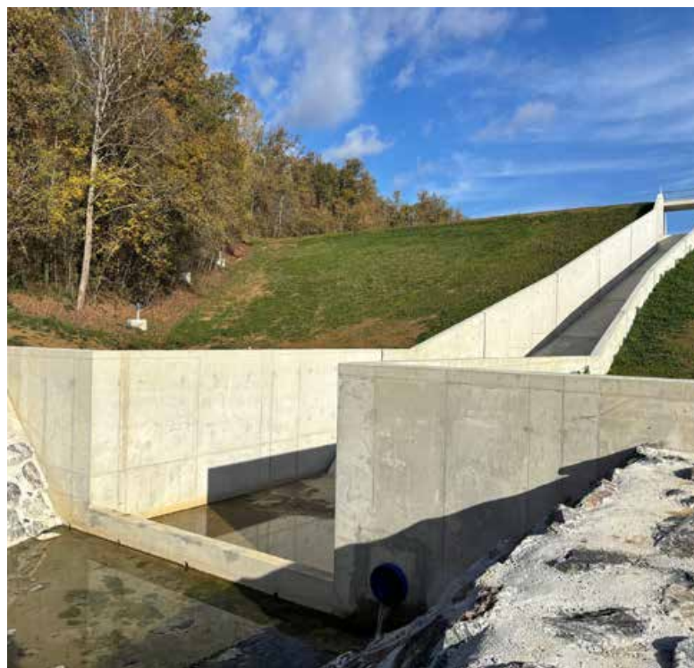
Barrage de Balerme - nouvel évacuateur de crues - photo DREAL
