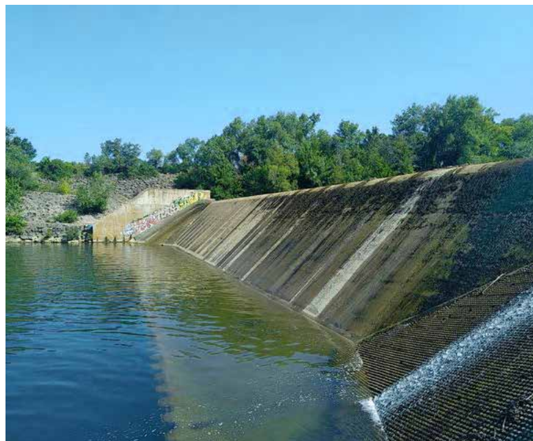
Pile rive droite du barrage de la Meuse, parement aval et rampe piscicole pour la montaison - photo DREAL Occitanie
