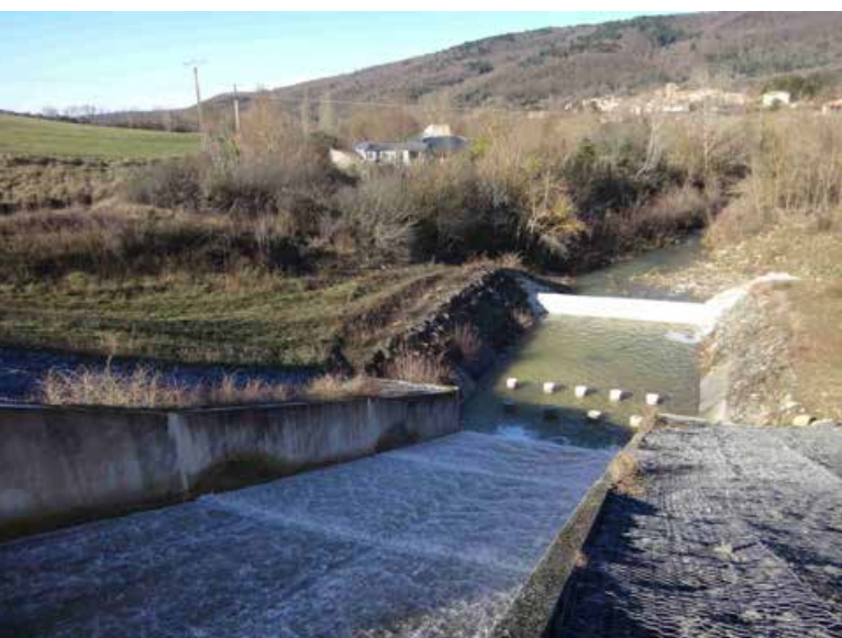
Sécurisation de l'évacuateur de crues - photo DREAL Occitanie
