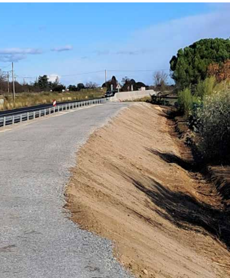
Confortement du tronçon aval du système d'endiguement de Mauguio - photo Pays de l'Or Agglomération
