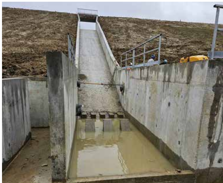
Évacuateur de crues du barrage de Bousquétara - photo DREAL
