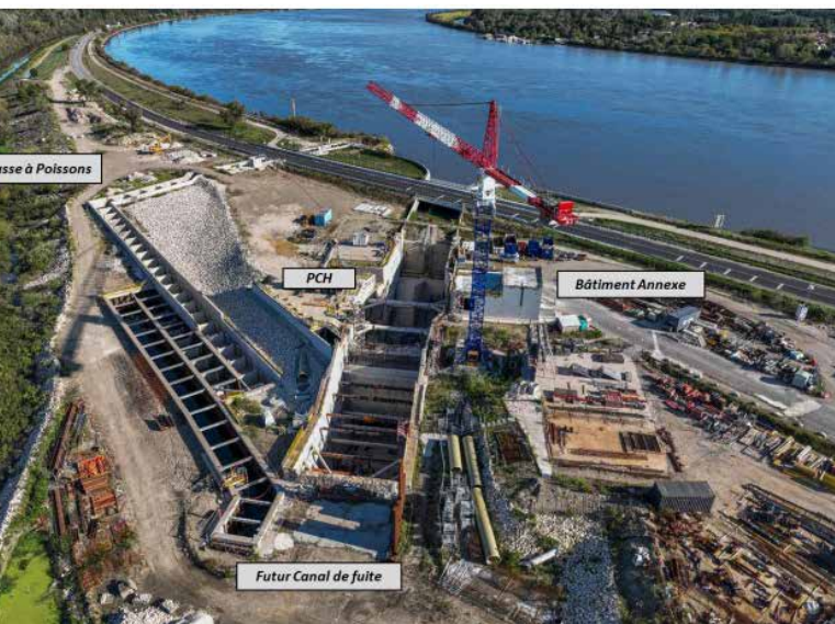
Vue aérienne du chantier en novembre 2024 - photo document CNR
