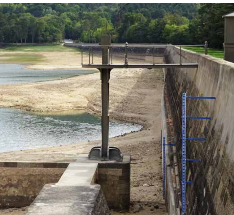
Parement amont du barrage de Saint-Ferréol visible lors d'une vidange - photo DREAL
