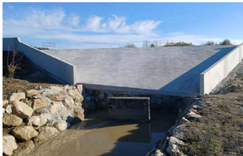
Barrage de Verdun-sur-Garonne, évacuateur de crues reconstruit – photo DREAL Occitanie
