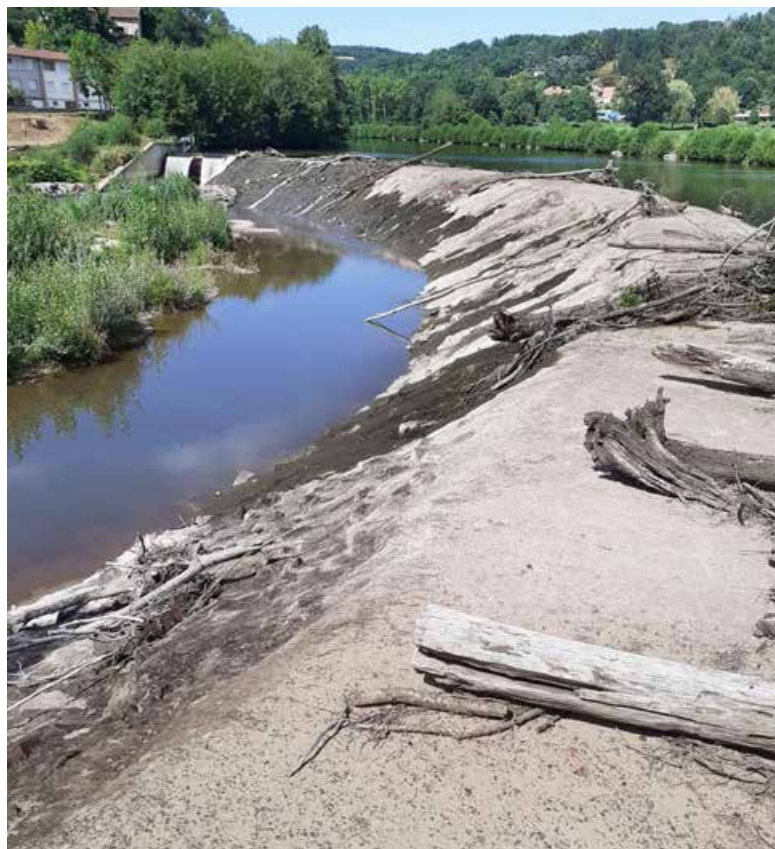
Seuil de Surgié avant travaux - photo DREAL Occitanie
