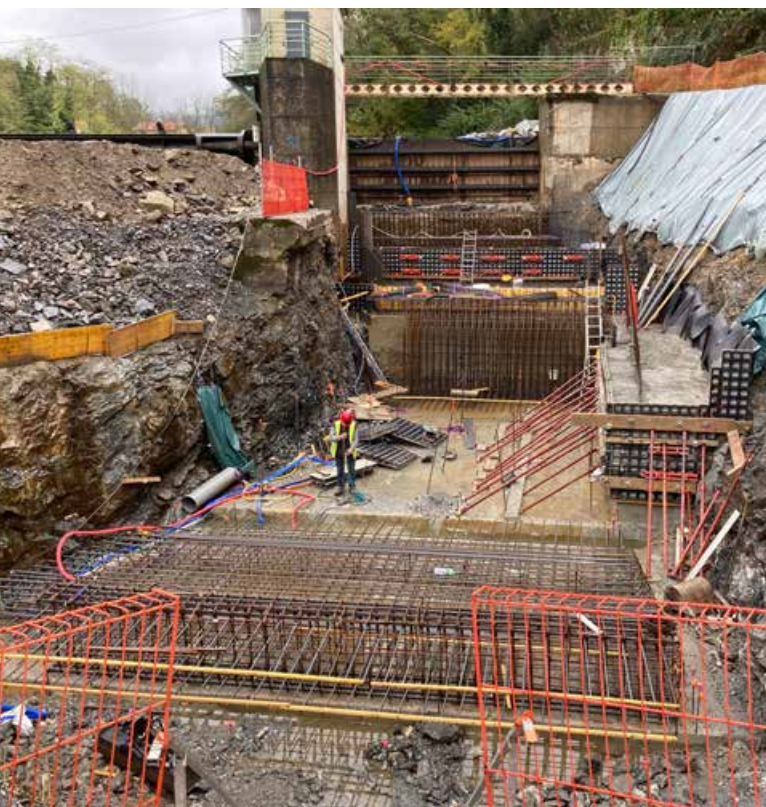
Pendant les travaux d'installation de la turbine VLH – photo DREAL Occitanie
