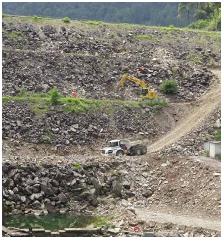
Réalisation des sondages sur le parement aval - photo DREAL Occitanie
