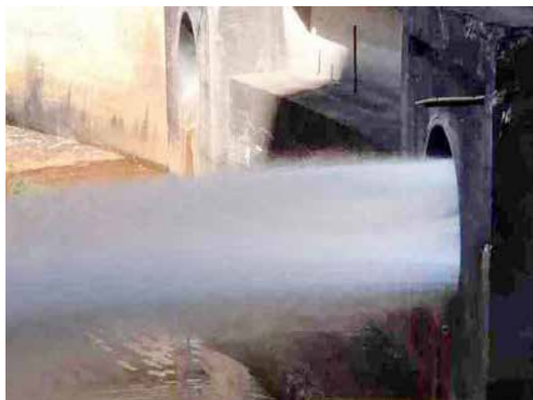
Barrage de Maury, essai de vanne intégrée à la mesure conservatoire – photo DREAL Occitanie
