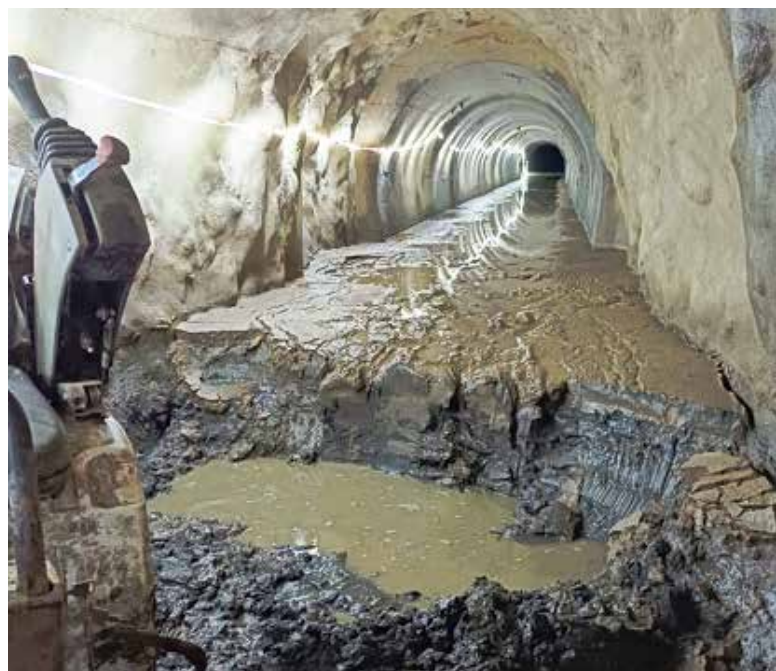
Curetage à la pelle mécanique de la galerie Badet – photo EDF
