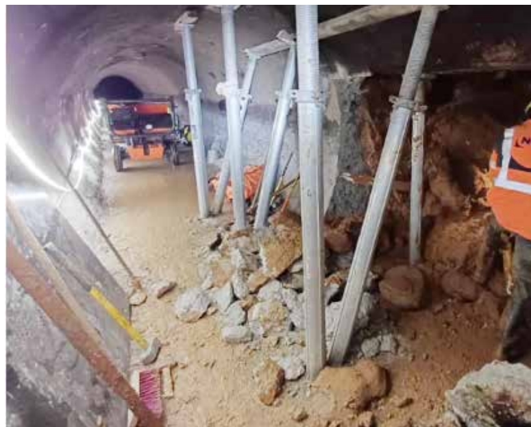
Galerie principale en travaux - photo EDF
