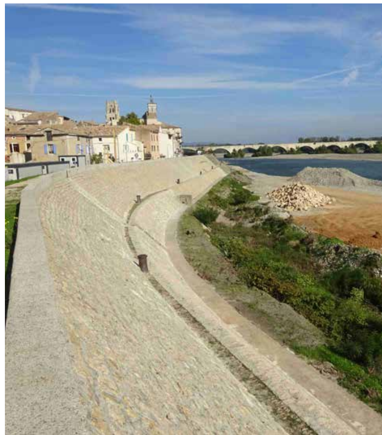
Digue du Rhône à Pont-Saint-Esprit (Gard) - photo DREAL Occitanie
