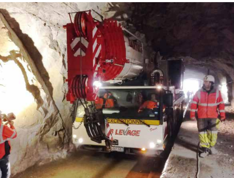
Fin de travaux d'agrandissement du tunnel d'accès - photo EDF
