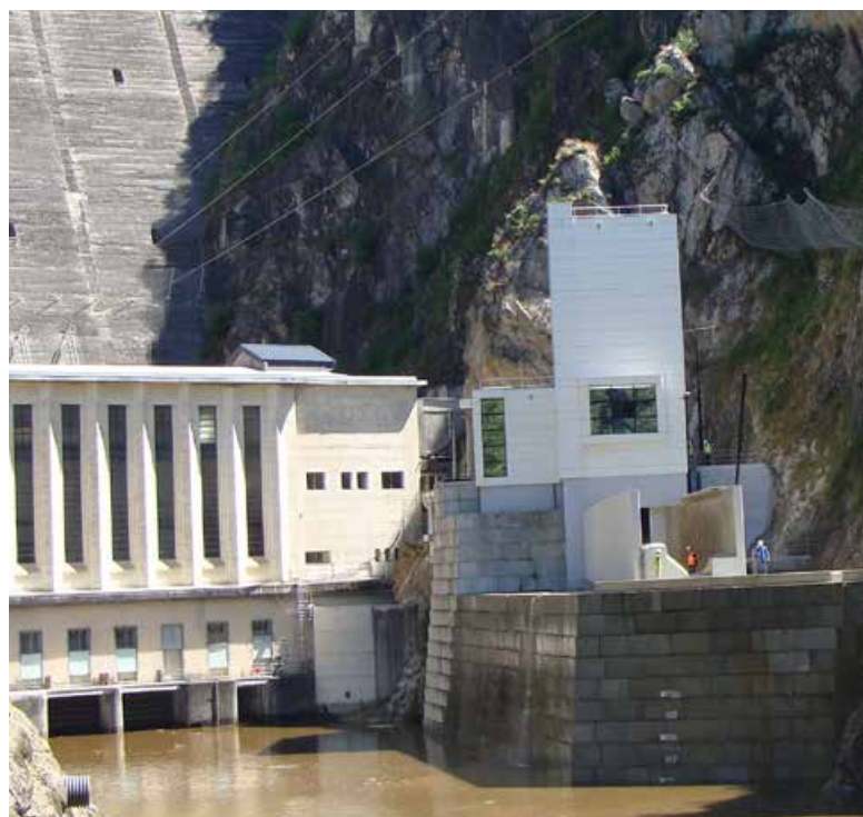
Barrage usine de Sarrans, nouveau local de vanne de fond - photo DREAL Occitanie
