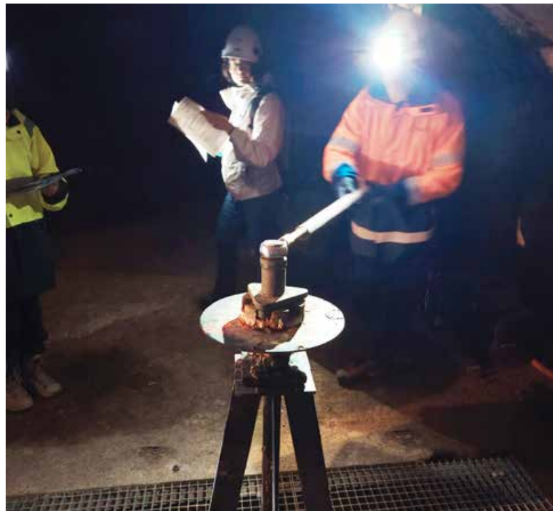
Délivrance manuelle des débits de lâchures – photo DREAL Occitanie
