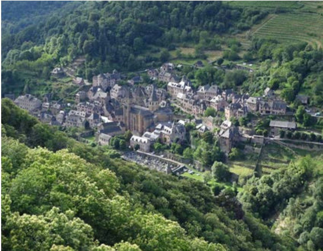
La qualité des restaurations menées dans le village de Conques depuis plusieurs décennies sert d'exemple et donne le ton. C'est l'effort de chacun qui permet une si belle réussite.
