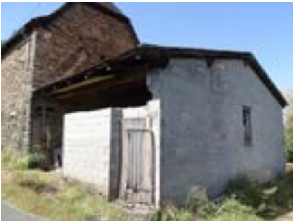
Etat actuel de l'appentis Extension accolée au pignon - volume de toiture à 2 pans avec cape(petite croupe), - maçonneries pierre et pans de bois.
