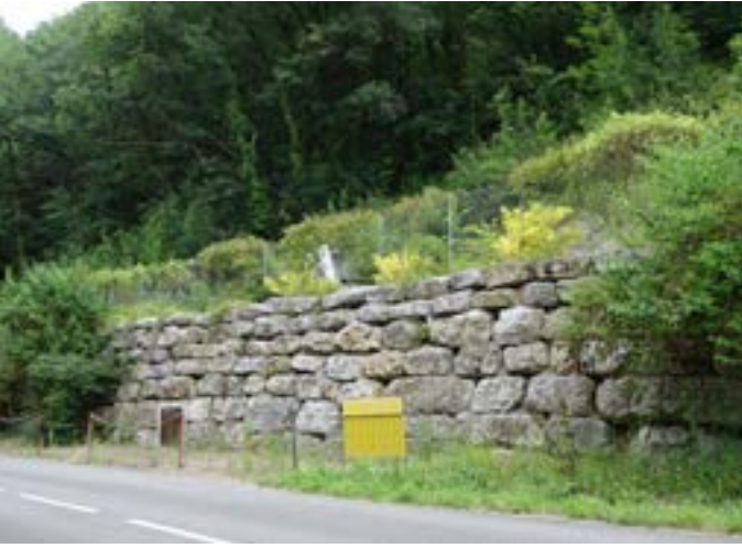
Station d'épuration, paroi en enrochements banalisante
