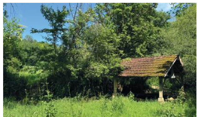
Lavoir couvert de Bouch/ ATPJC
