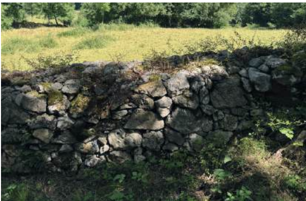
Muret pierre sèche traditionnel
