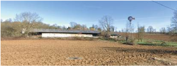
Bâtiments agricoles isolés Intégration paysagère des bâtis : Le Roudès, Sentenac
