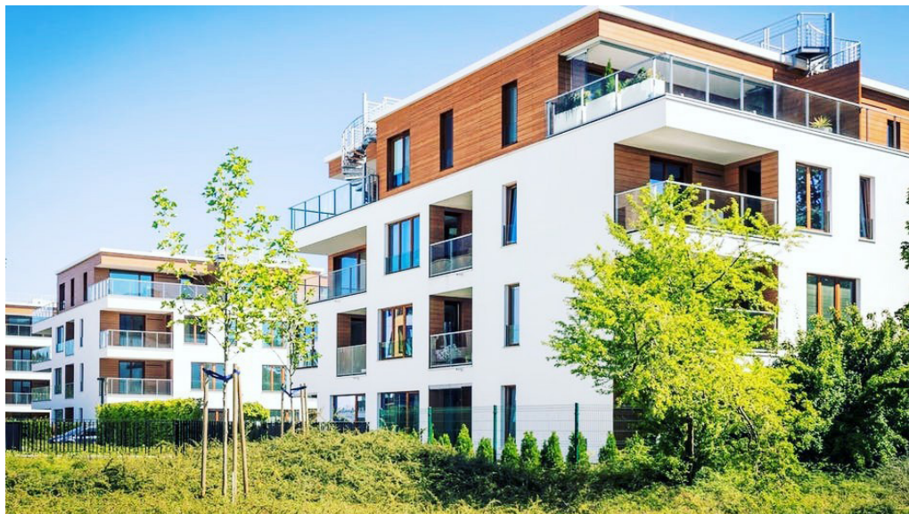
Aude | Narbonne réhabilitation et construction de logements sociaux
