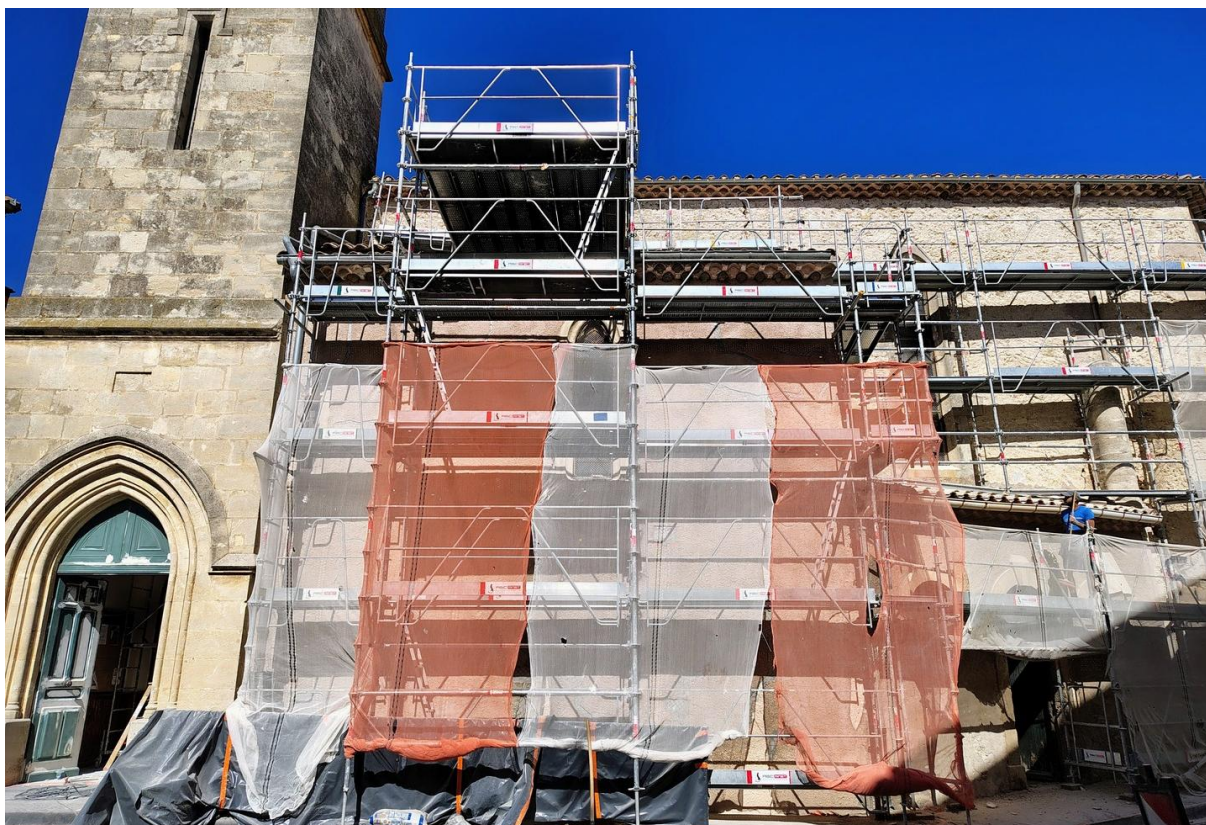
Aperçu des travaux de sécurisation et réhabilitation de l'Eglise Saint-Geniès de Cers - CBE
