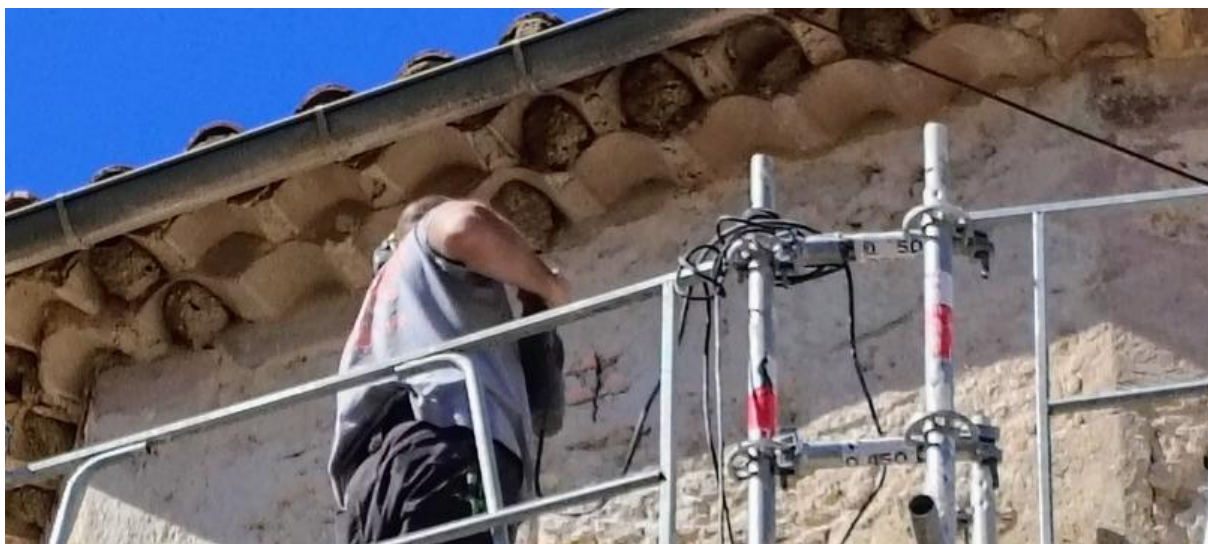
Travaux à proximité immédiate des nids – CBE
